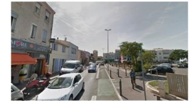
1. Chemin le long de la corniche
