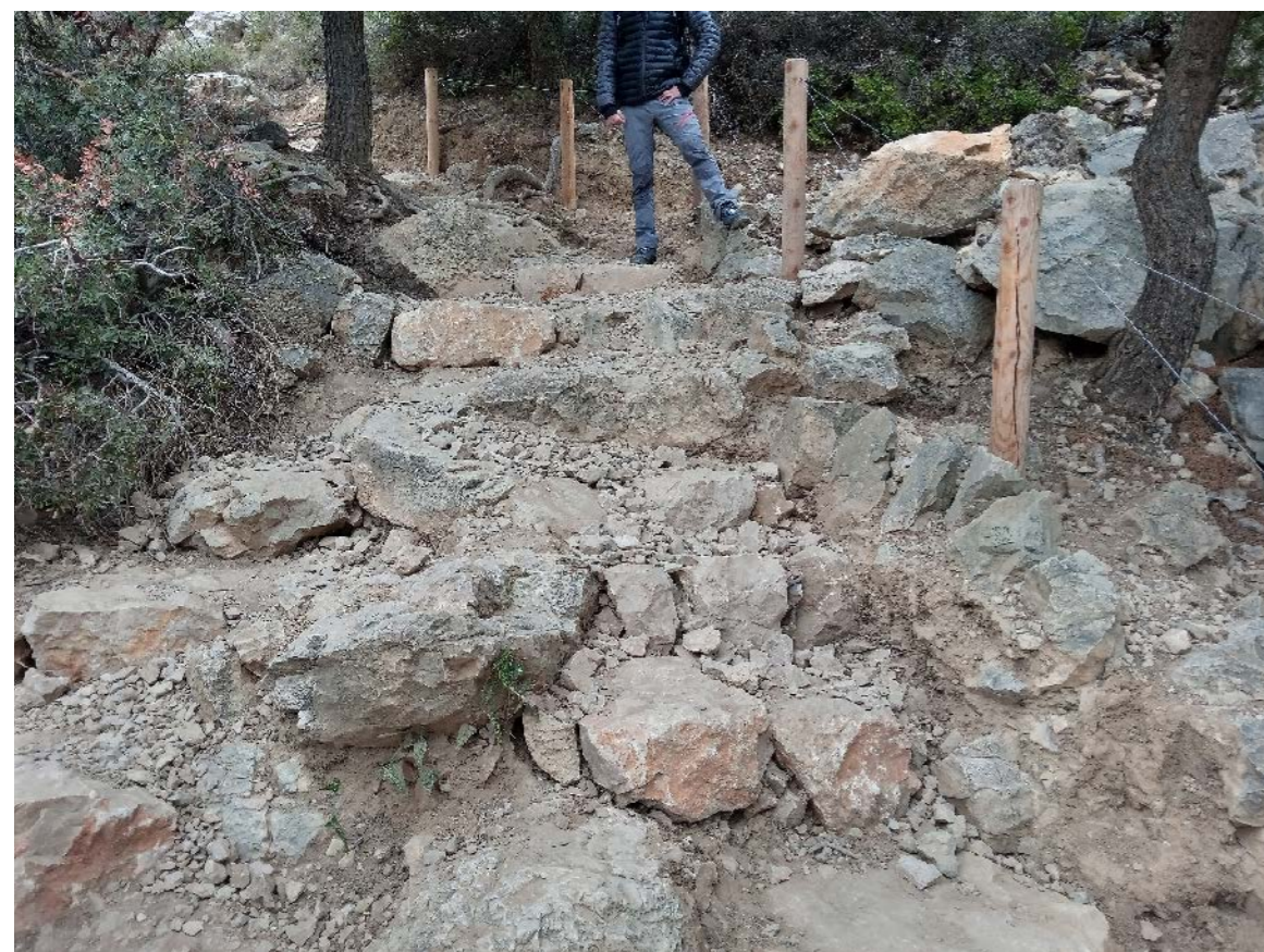
Emmarchement dit «en pas japonais» réalisé dans le cadre de la mission Life dans la calanque de Sugiton.
