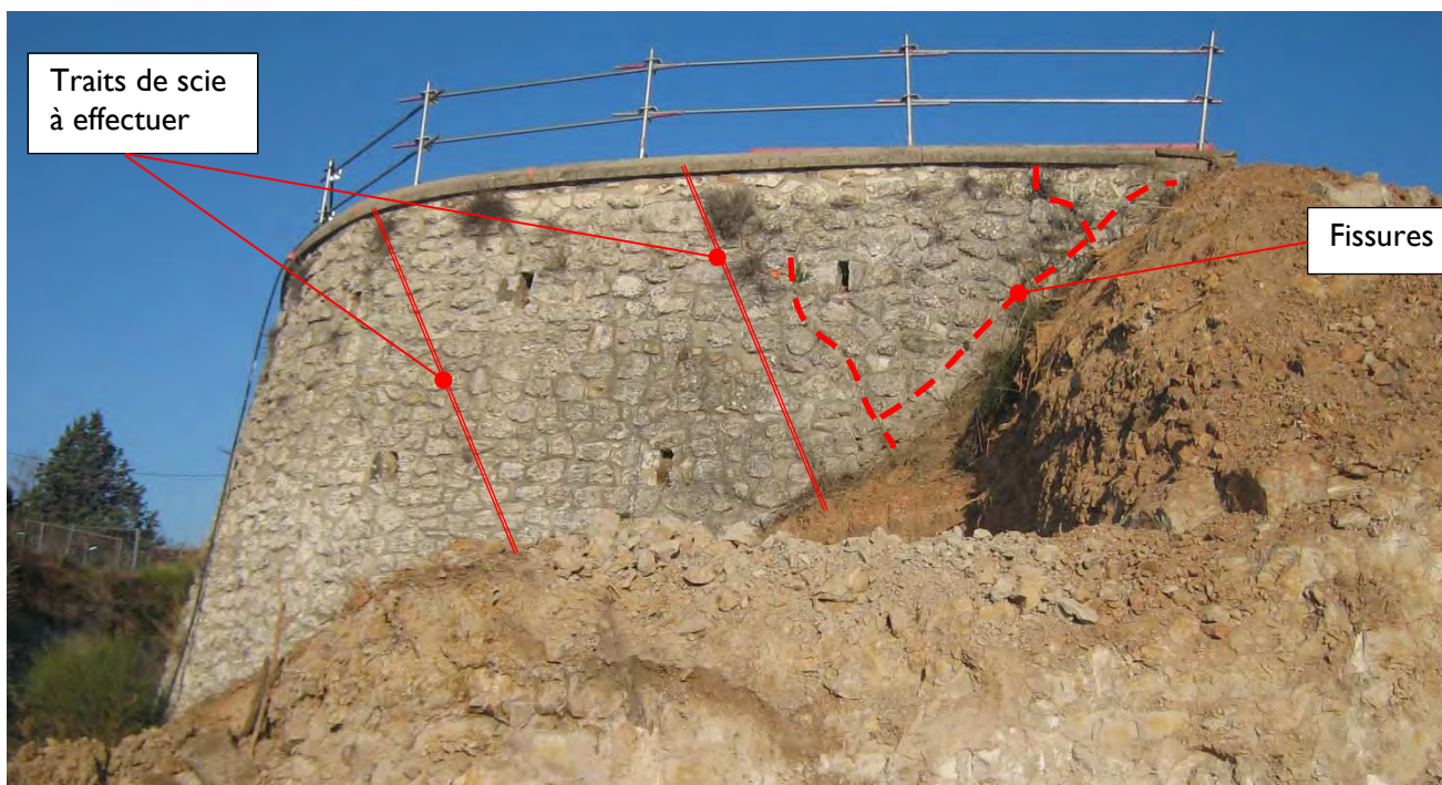
Vue du retour du mur maçonné (fissures en biais surlignées en rouge)
