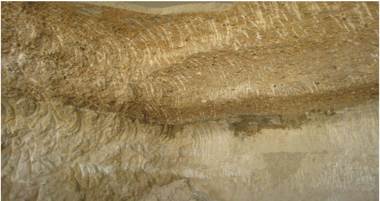
Trace d'humidité entre les poudingues et la couche marneuse.
