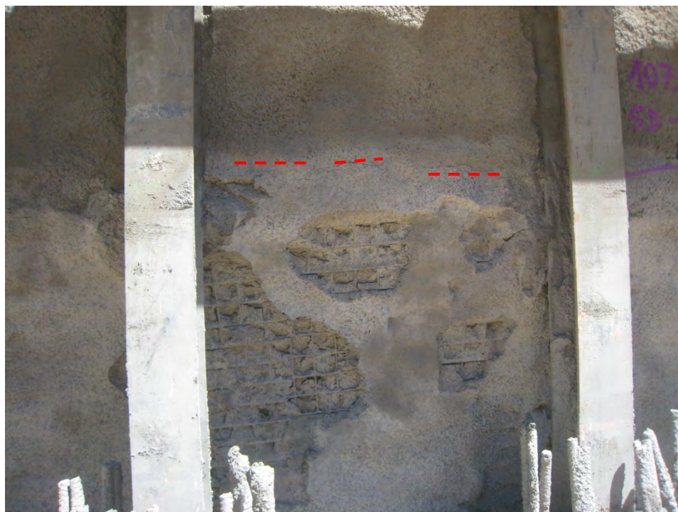
Décollement de plaque de béton (fissures surlignées en rouge)
