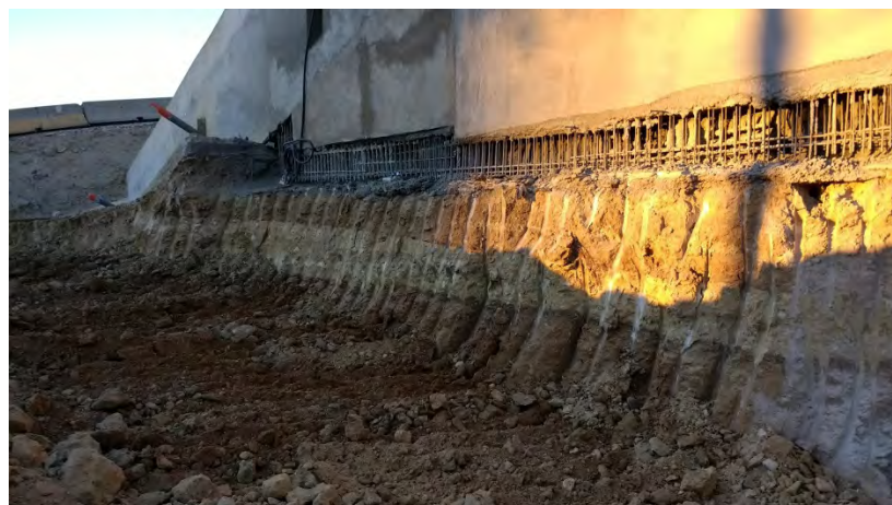
Dépôts de remblais anthropique stratifiés et constitués de graves et sables fins à argileux
