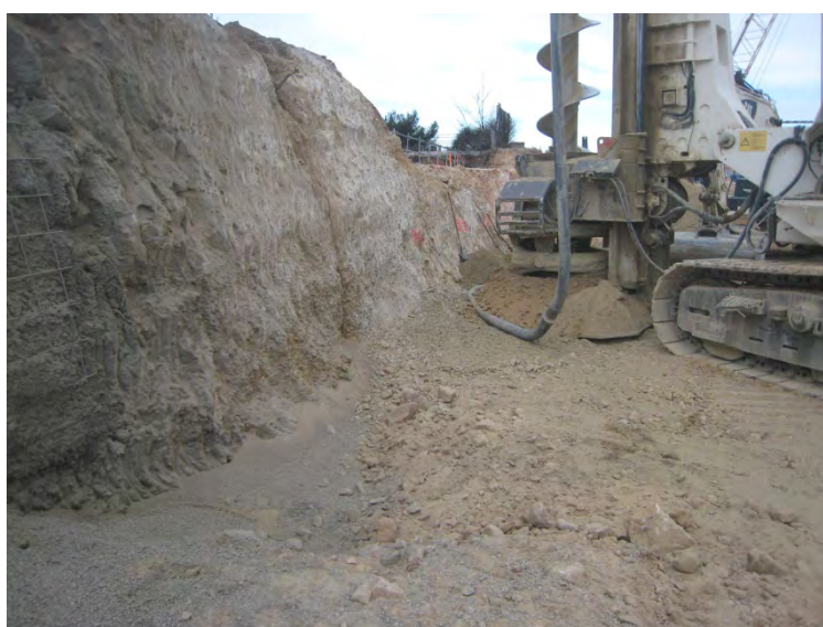
Fracture subverticale en sortie de la zone confortée
