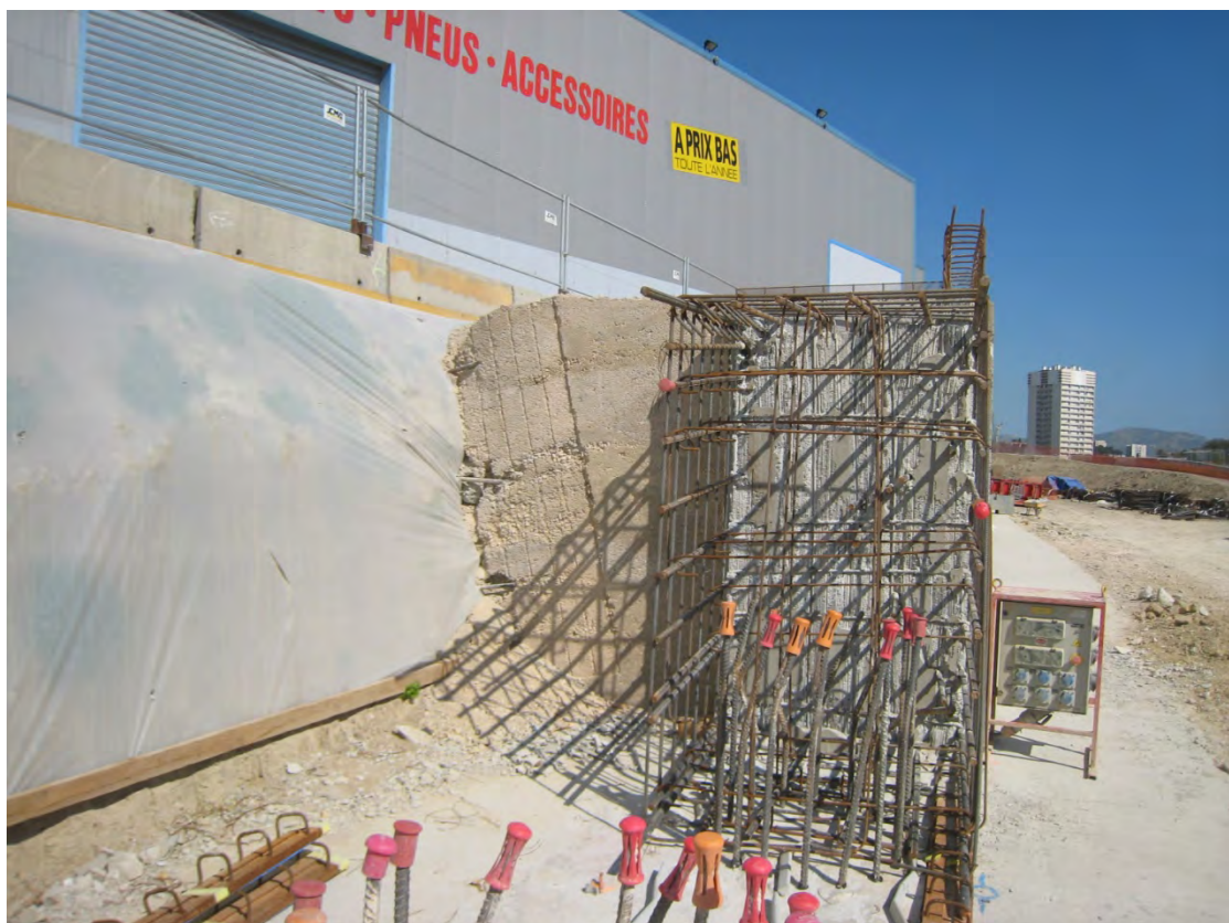
Grave ciment à l'arrière de la poutre de couronnement et bâche sur les talus provisoires
