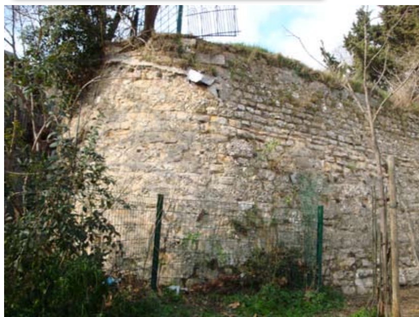
Mur de soutènement coté Sud (Aire des chiens): appareillage pierres sèches avec enduit
