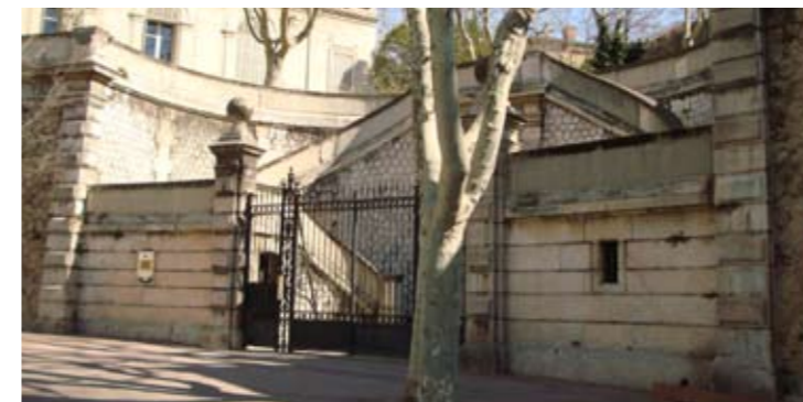
Entrée 11: Sur la place Leverrier entrée condamnée
