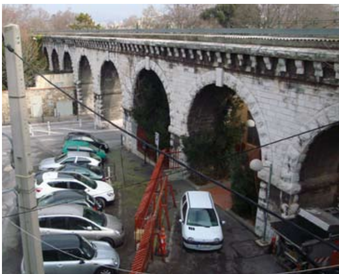
4. Vue Est de l'aqueduc, place Louis Rafer
