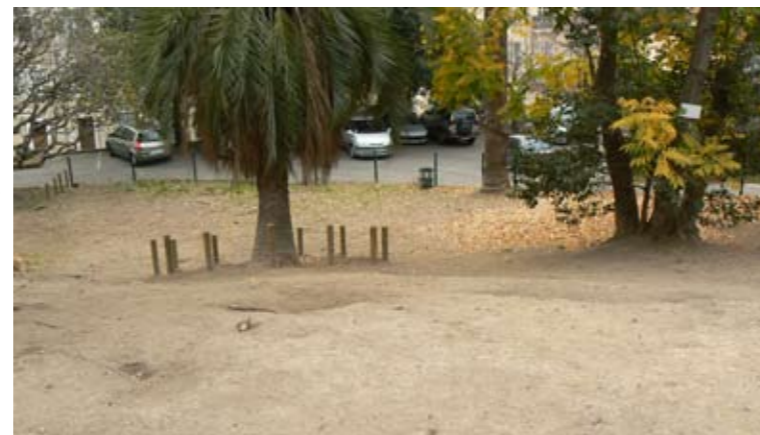
5. Parc à chien: mauvais état des pelouses, érosion des sols préjudiciable à la végétation
