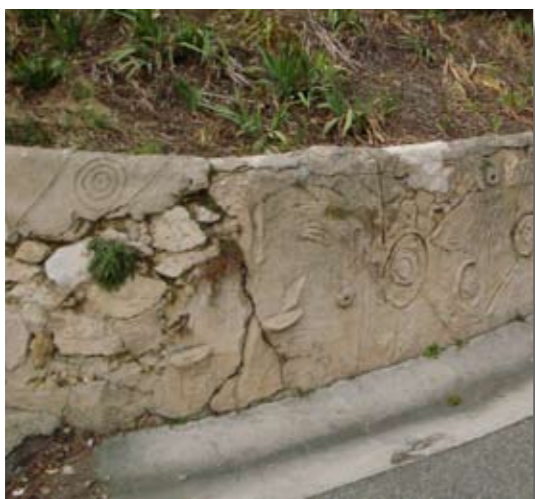
6. Ancien jardin zoologique Sud: mur en moellons avec reste d'enduit rocaille
