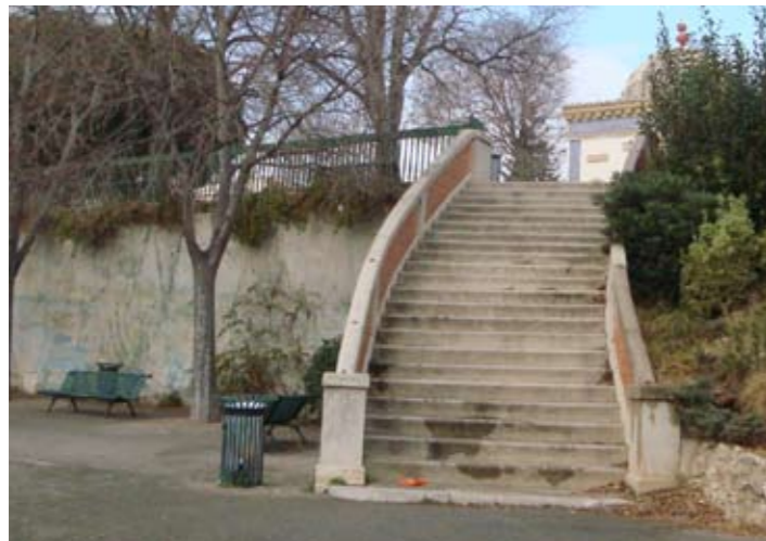
4. Ancien jardin zoologique Escalier d'origine mais complètement modifié (garde corps, revêtement)
