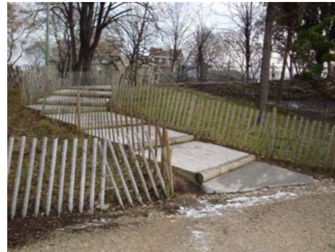
3. Ancien jardin zoologique: escalier en béton réalisé récemment (année 2000)
