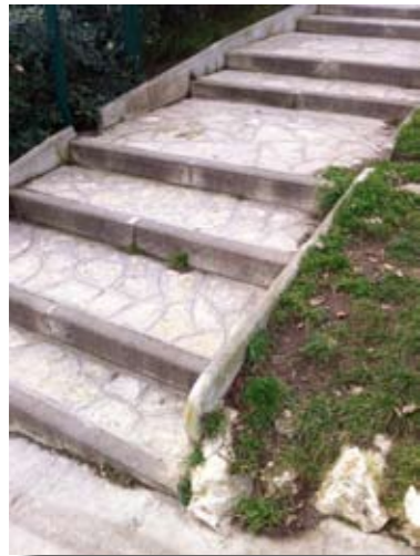
1. Ancien jardin zoologique: Escalier béton avec bordure béton et dalle de pierres
