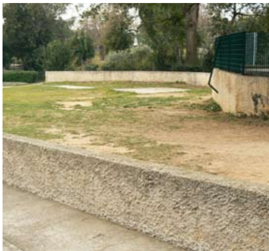
3. Ancien jardin zoologique Nord: muret en maçonnerie enduite
