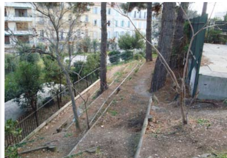
6. Restanques en bois surplombant la bouche de Métro.
