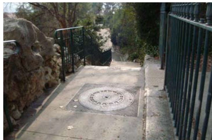
4. Ancien jardin zoologique: Escalier, volée Sud: on constate la présence de pierre sous le revêtement béton. Imitation rocaille en ciment
