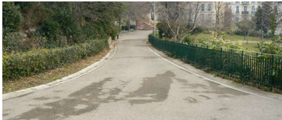
2. Ancien jardin zoologique: cunette béton
