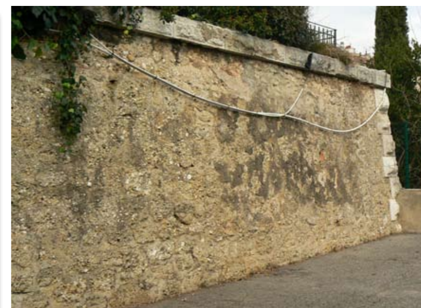
Mur en poudingue (coté bd Cassini), avec chaînage d'angle à bossage et corniches en pierre
