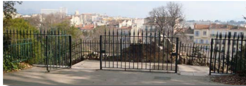
4. Grille d'origine séparant l'escalier de la cascade et le plateau
