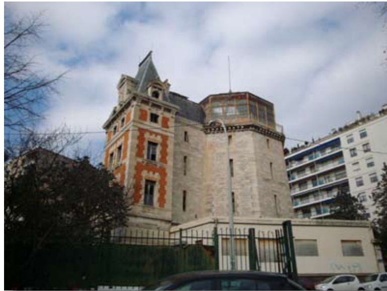
1. Le Tore - Bâtiment du XIX e siècle (1898-1901)
