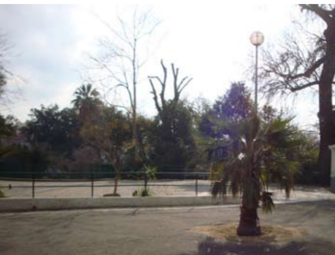
7. Ancien jardin zoologique : dalle en béton
