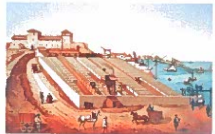
Réalisation de blocs de béton pour la construction de la digue du port
