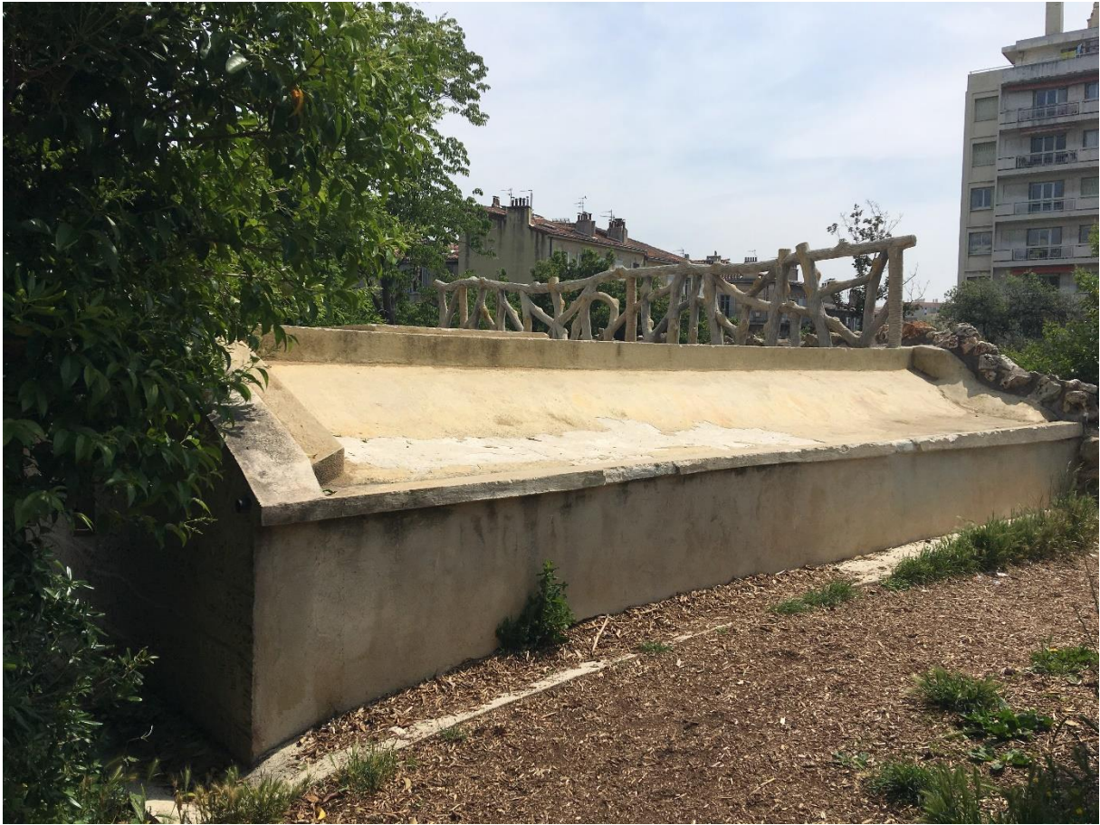
Détails de l'arrière des cages des ours en 2018. On remarque le style rocaille typique de l'architecture paysagère de la fin du XIX e siècle avec l'utilisation de rondins de bois décoratifs contrastant avec le dénuement du béton et la simplicité de l'arrière de la structure, non visible par le public. Cliché C.Borrely
