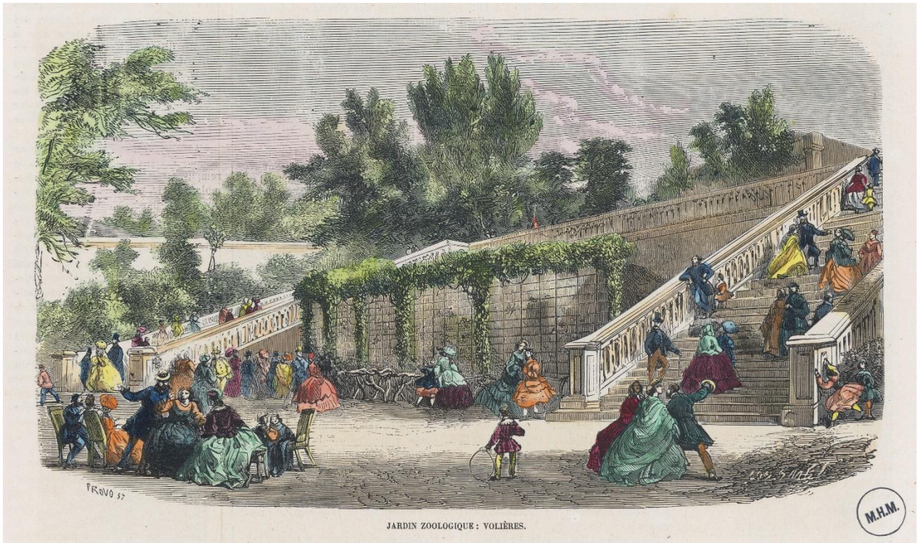
Les volièrès du Jardin zoologique de Marseille, dans la première partie du Zoo, entre les escaliers qui conduisent au kiosque à musiques et à l'enclos de la girafe. Musée d'Histoire de la Ville de Marseille.
