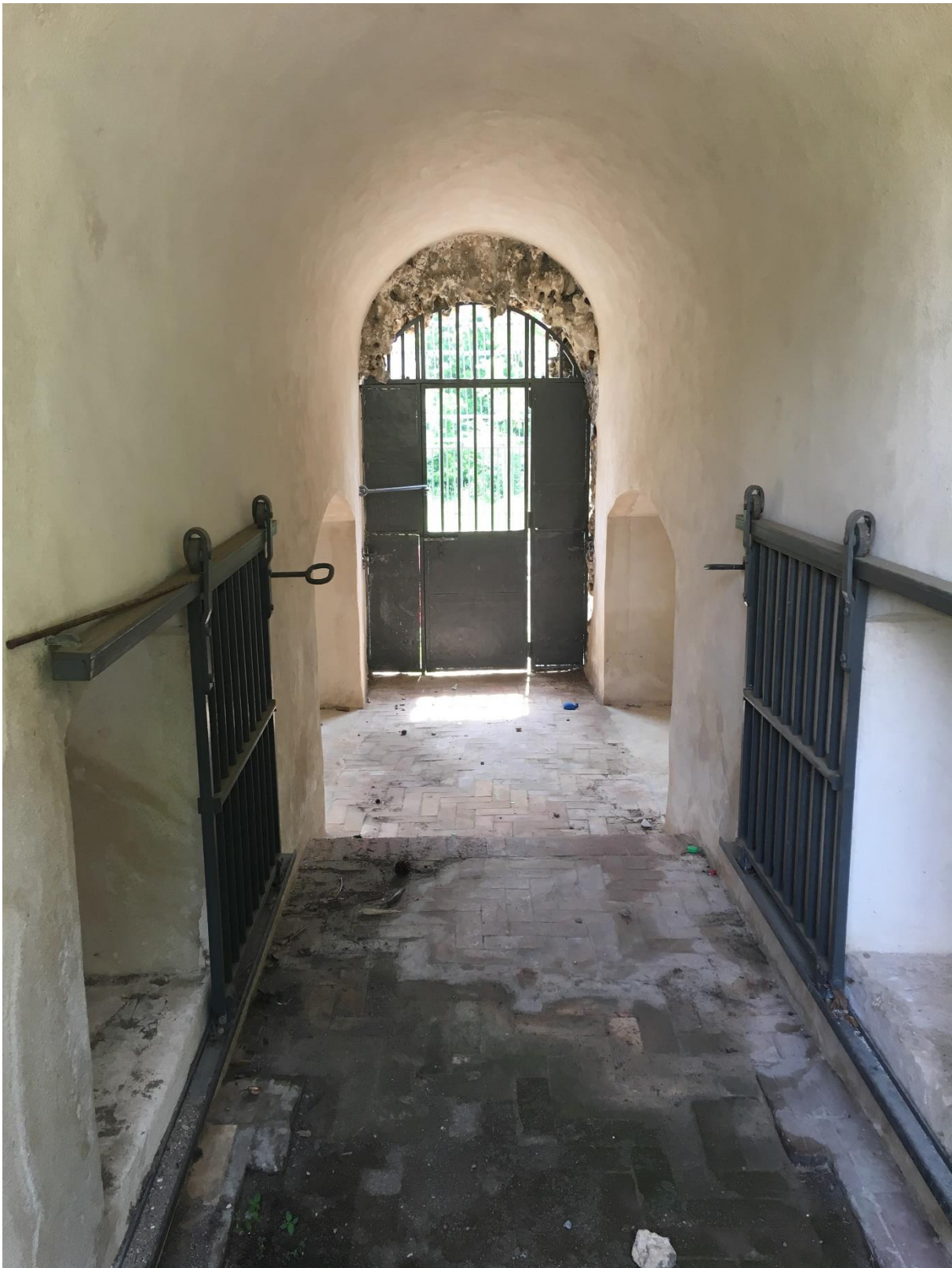
Cages des ours en 2018. Détails du couloir de service et des loges intérieures des ours. La grille à l'arrière-plan de la photographie est le sas de communication avec la cage extérieure et permettait d'isoler les animaux pour la nuit à l'intérieur. Cliché C.Borrely
