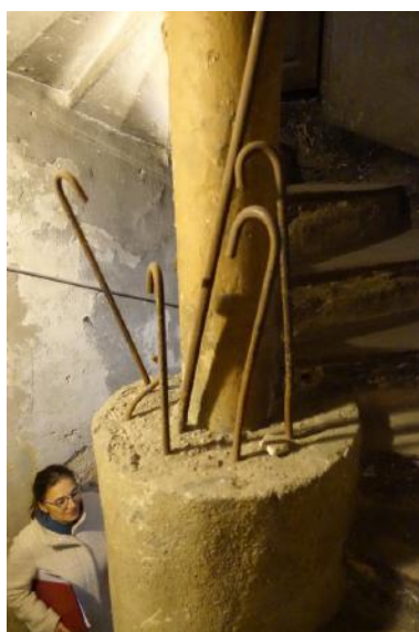
Figure 14: Chemisage BA - Liaison intime avec le fut - Maintien en place
