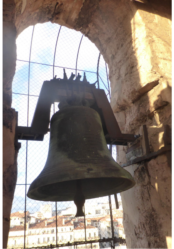
Cloche Ouest avec mouton en acier
