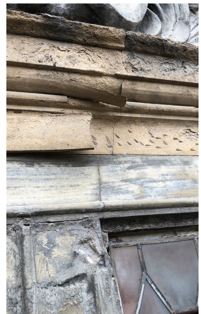
Photos état des lieux de la fausse menuiserie en ciment et vitrail
