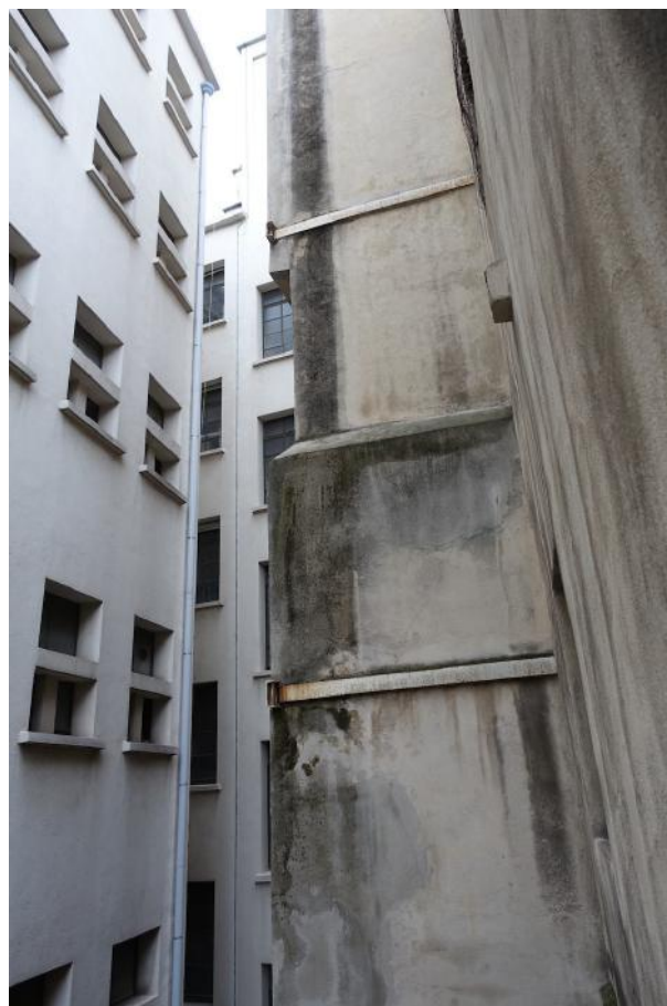
Figure 6: variation d'épaisseur du mur de la cage d'escalier - sondages en attente
