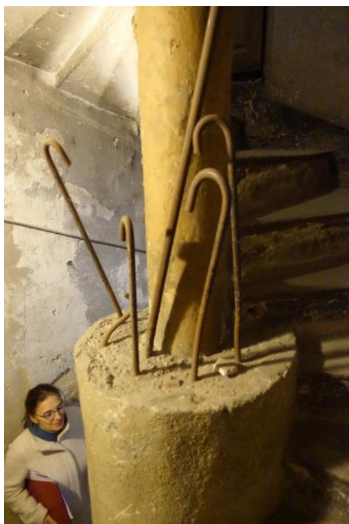
Figure 10: fût rechapé en béton armé
