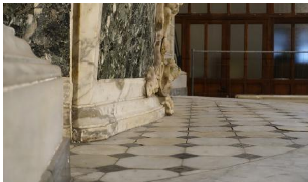
Figure 3: déflexion carreaux au pied de l'embase
