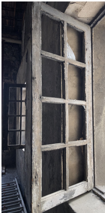
Menuiseries de la salle du niveau 2, à remplacer à l'identique.
