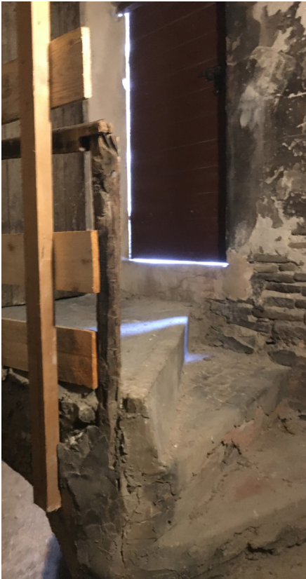
Dernière volée à démolir et à rebâtir entièrement (17 marches)
