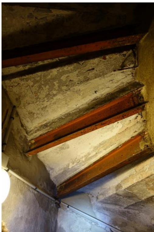
Figure 8: renforcement de quelques marches par IPN
