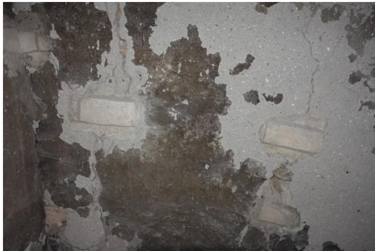
Figure 4: témoins en partie supérieure de la cage - date 1935 - témoins intacts
