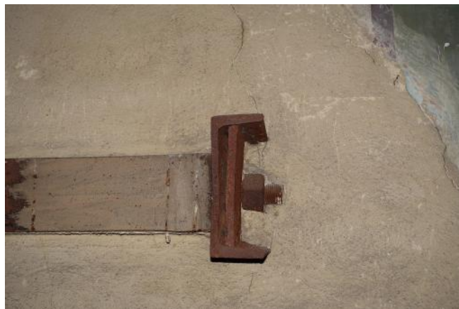
Figure 13: vue du dispositif de ceinturage métallique
