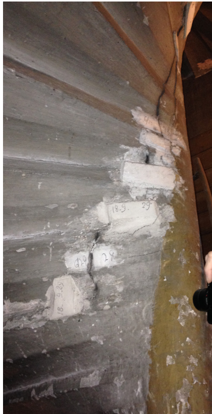
Dépose des consolidation antérieures et remaillage des fissures
