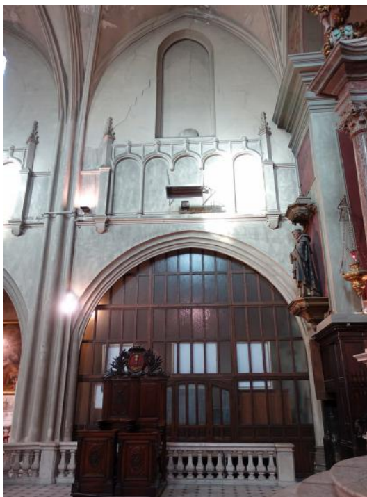
Figure 17: fissure sur tympan de bas côté - figure d'extension Ouest - Est
