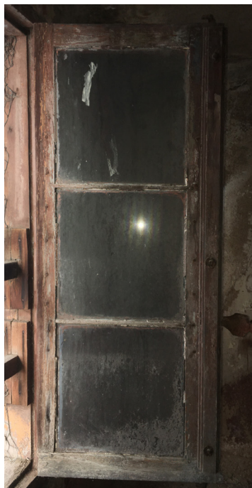
Menuiseries bois à grands carreaux des salles du niveau 1, à restaurer.
