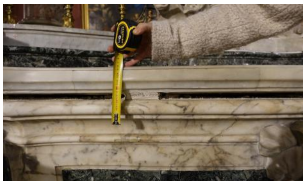
Figure 1: décollement relatif entablement embase
