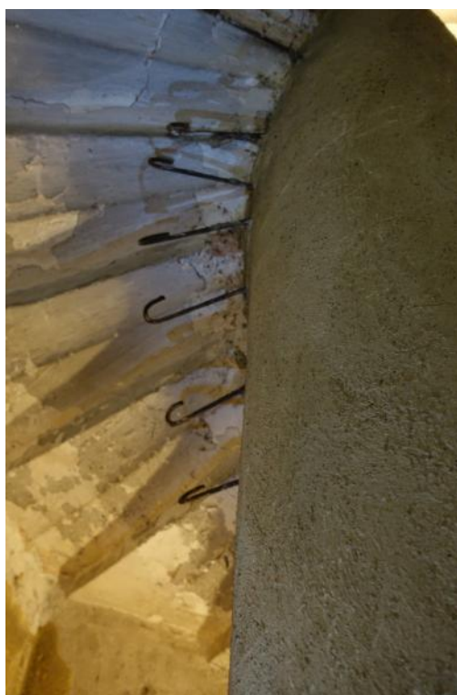
Figure 11: attentes pour liaison avec un renforcement de la paillasse
