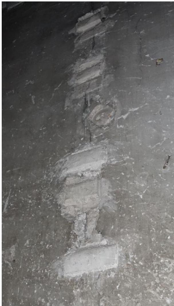
Figure 5: série de témoins montrant que les mouvements sont stoppés en 1935
