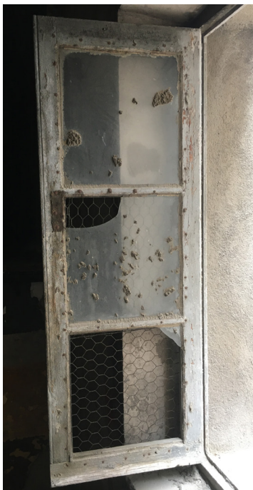
Menuiseries bois à grands carreaux des salles du niveau 1, à restaurer.
