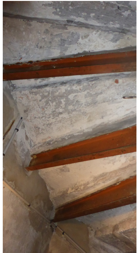
Dépose des consolidation antérieures et remaillage des fissures
