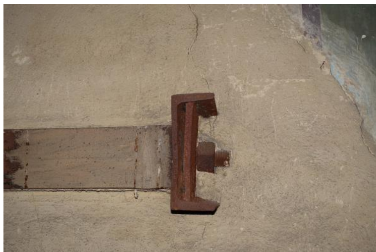
Figure 7: vue du dispositif de ceinturage métallique
