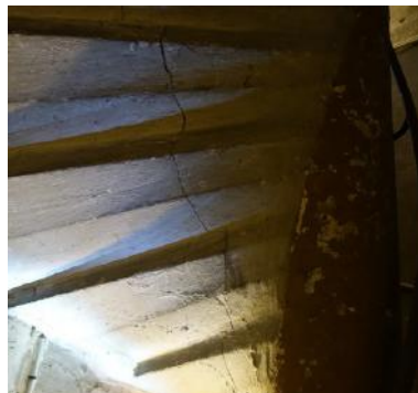
Figure 15: fissure à brocher
