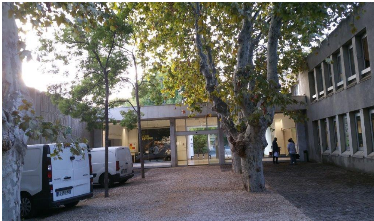
Vue Générale. Hall d'entrée
