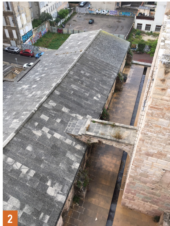
Vue générale de la toiture A - Nef Vaisseau central en dalles de pierre
