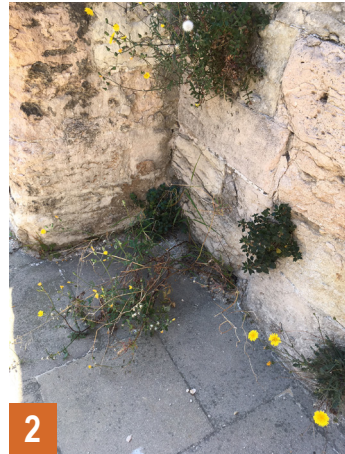
2 Végétation sur les murs et sur angle du mur de la terrasse (E)
