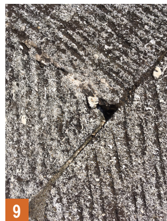
9 Détail sur dalle en pierre, avec joints ouverts et passage potentiel d'eau (A)
