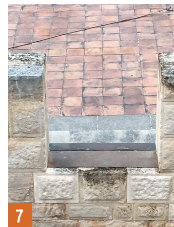
Détail des couvertines et solins en cuivre Tour Isarn
