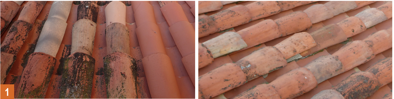
▲ Photographies (1) : colonisation biologique sur les tuiles à nettoyer lors des travaux d'entretien - remplacement des éléments défectueux le cas échéant.
