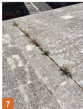
7 Joint transversal de rupture sur la nef (A)
