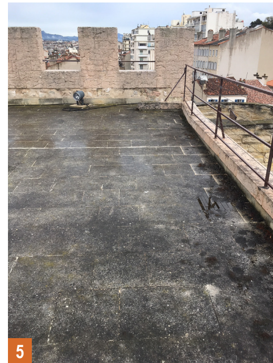
Couverture de la toiture H - Tour Urbain V en dalle de pierre
