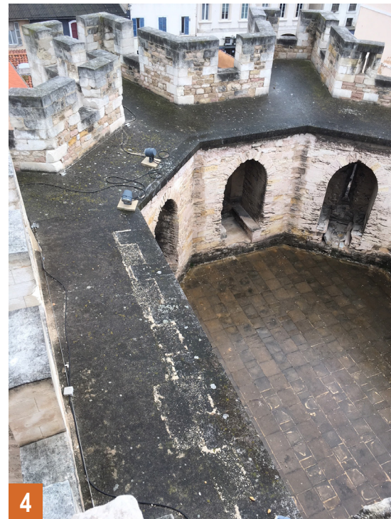
Couverture de la toiture G1 - Choeur en dalles de ciment
