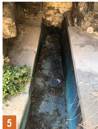
5 Chéneau qui part vers la descente EP noyée dans la maçonnerie qui descend vers la sacristie (G1)
