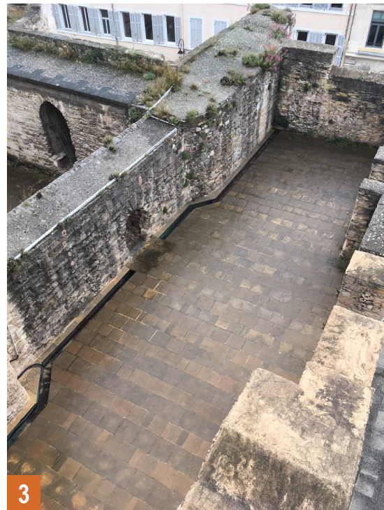
Couverture de la toiture E - Transept en dalles de ciment
