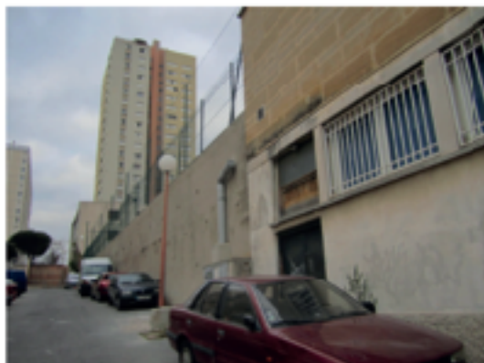
Vues mur de soutènement terrain d'évolution
