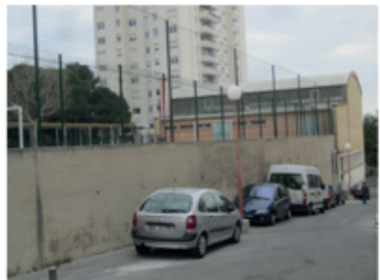
Vues mur de soutènement terrain d'évolution
