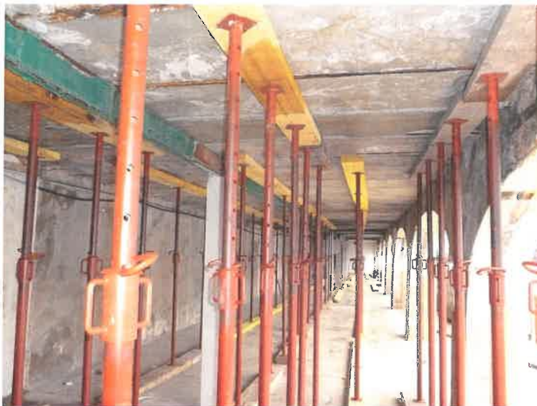
Etalement des vouîains avant travaux
