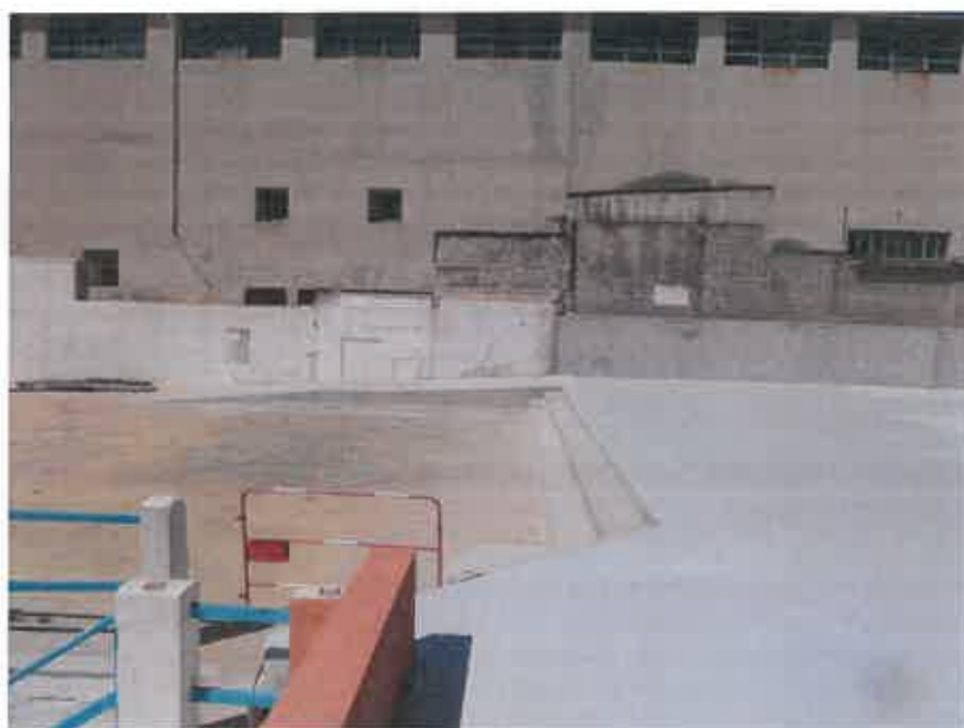
Rampe PMR coté cercle des nageurs donne accès à la plate-forme existante.
