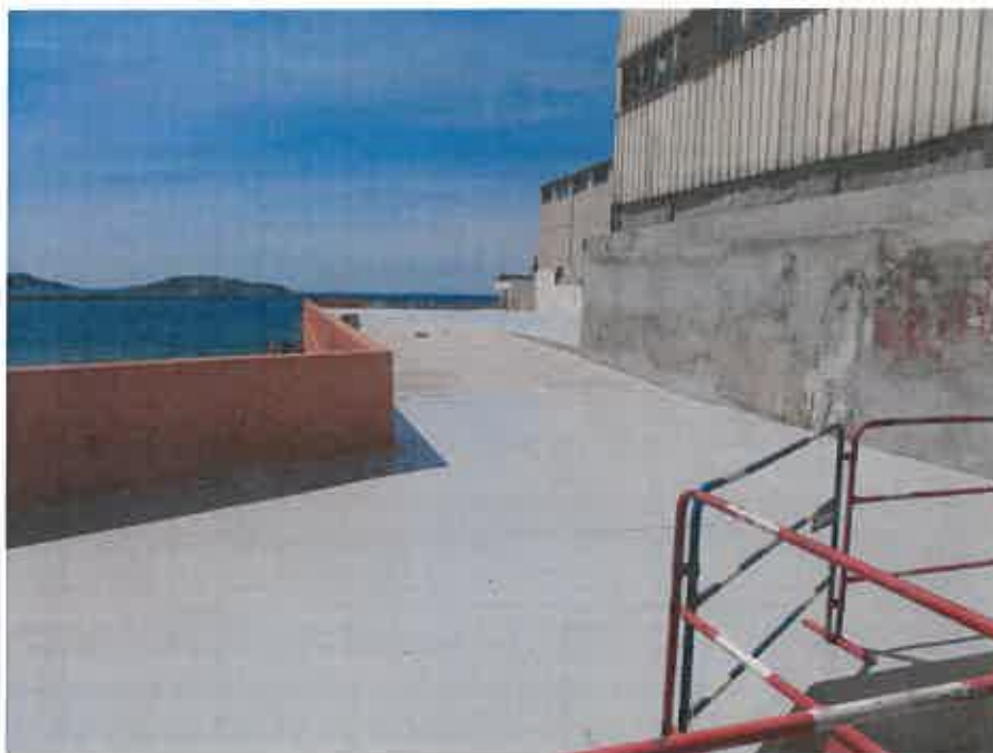
Rampe PMR côté rue des Catalans donnant accès à la plate-forme (plancher du Réal Club)
