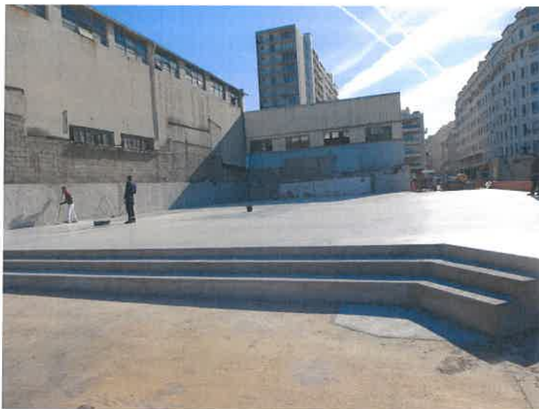
Escalier béton côté cercle des nageurs
