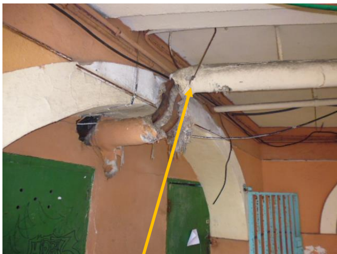
Calorifugeage + enveloppe suspects Alcôve 1
