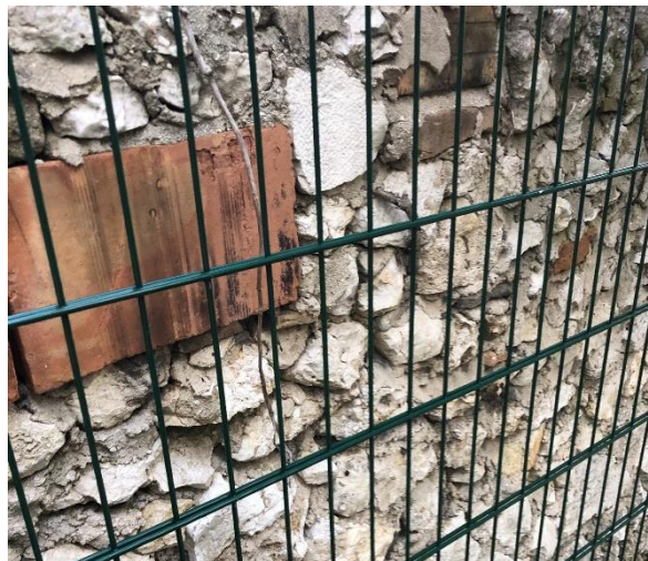
Jointement des pierres dégradé
