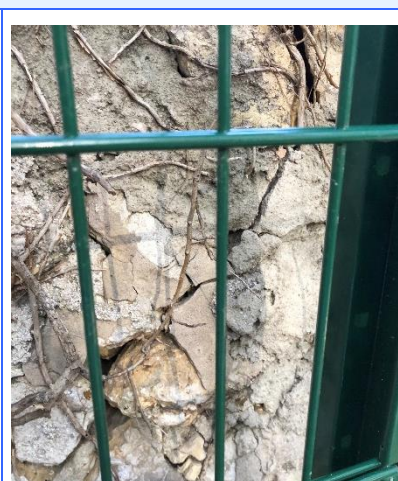
Jointement des pierres dégradé
