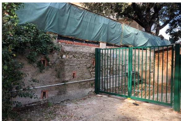
Mur en béton banché cyclopéen
