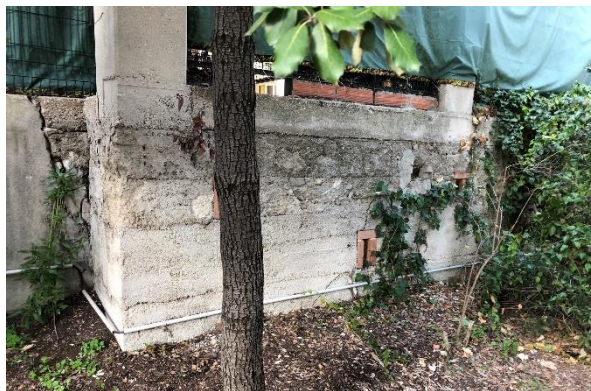
Mur en béton banché cyclopéen
