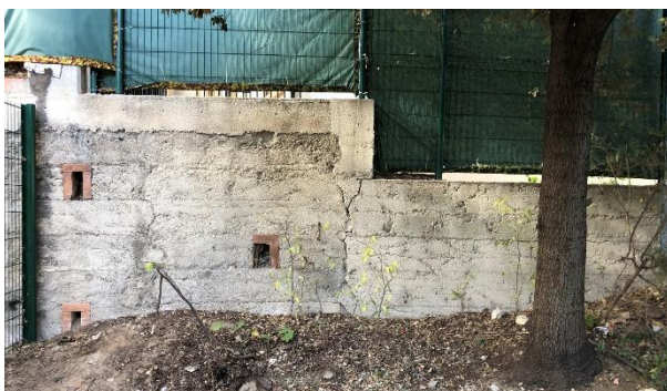
Extrémité droite avec différence de hauteur
