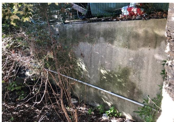
Partie centrale du mur
