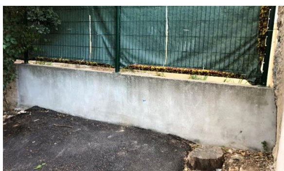
Mur en agglos de 20 enduits
