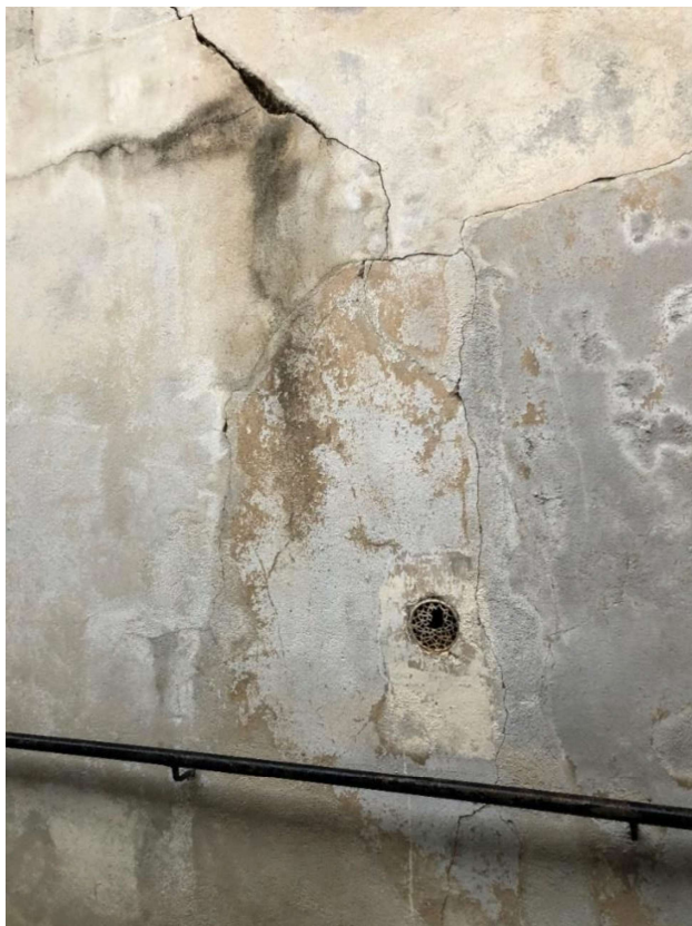
Fissure centrale du mur (à gauche) et fissure oblique sur le palier (à droite)
