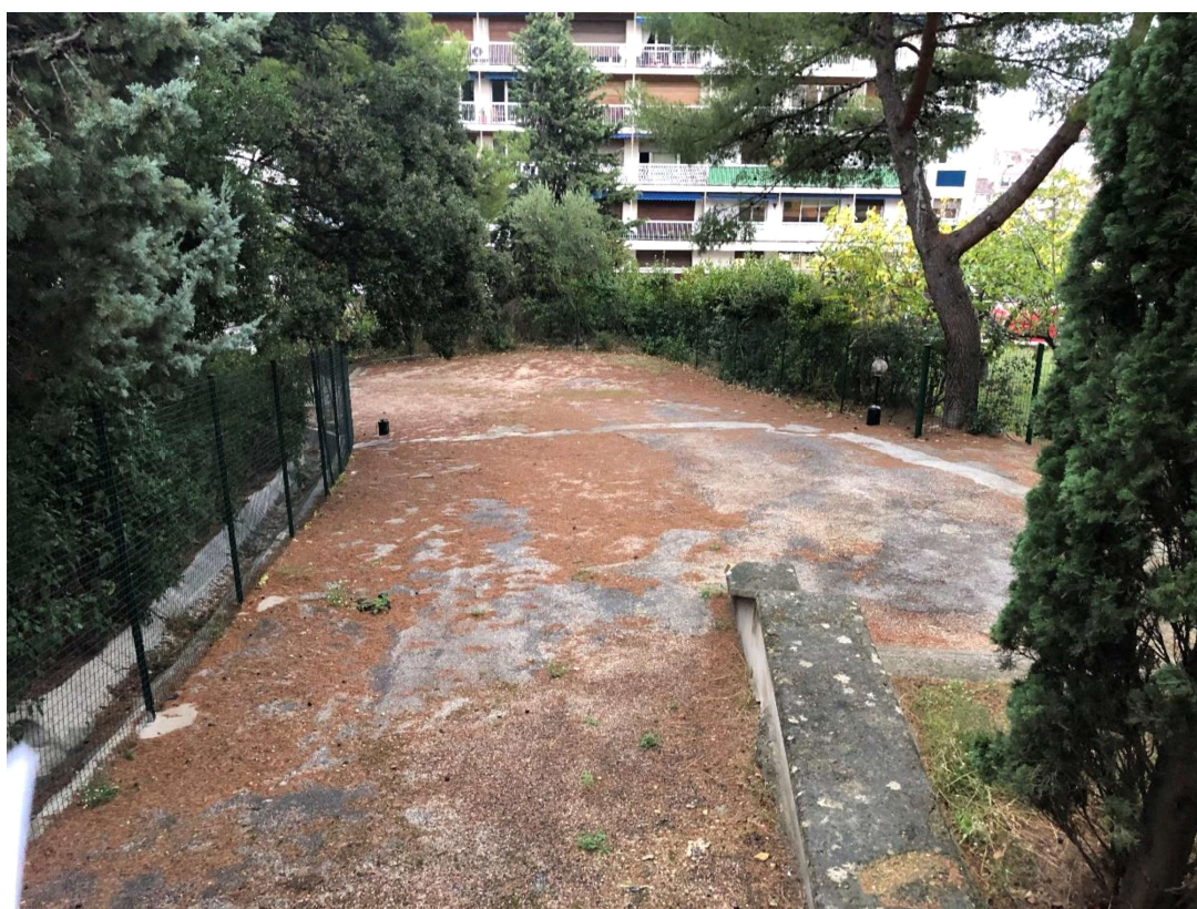
Vue de la troisième zone, en partie aval du site, photo (3)
