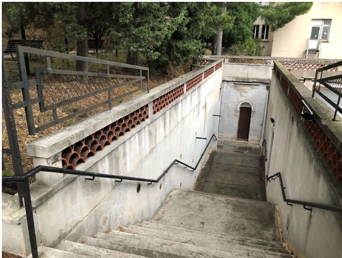
Vue du mur de soutènement de l'escalier, en partie aval, photo (4), sujet du diagnostic géotechnique
