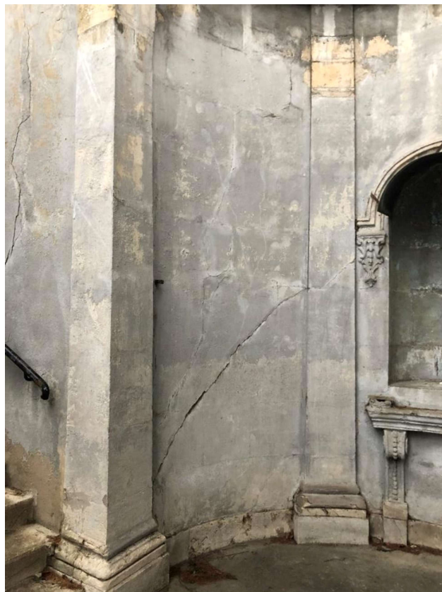
Fissure centrale du mur (à gauche) et fissure oblique sur le palier (à droite)
