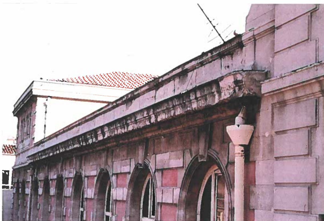
• PHOTO N° 19 - Etat de dégradation de la corniche - Le larmier a disparu en totalité -
