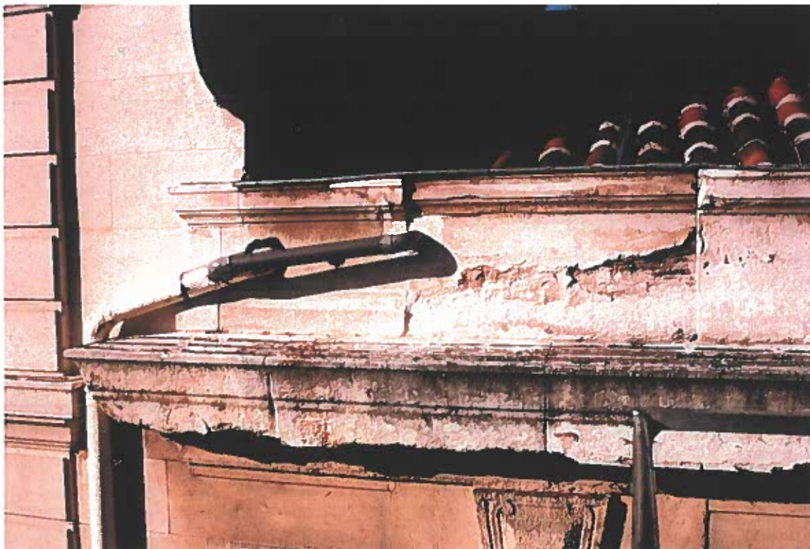
• PHOTO N° 12 - Aile Sud - Détail sur altération de la corniche et importantes pertes de matière - Altérations de surface extensives -
