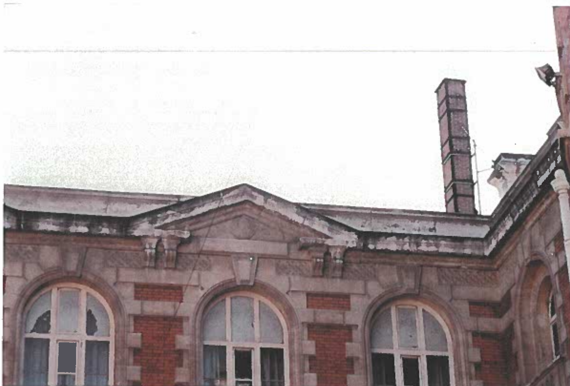
• PHOTO N° 19 - Bâtiment principal - Façades sur cour - Exemple d'altération des corniches - Noter la cheminée de la chaufferie renforcée par une structure métallique -
