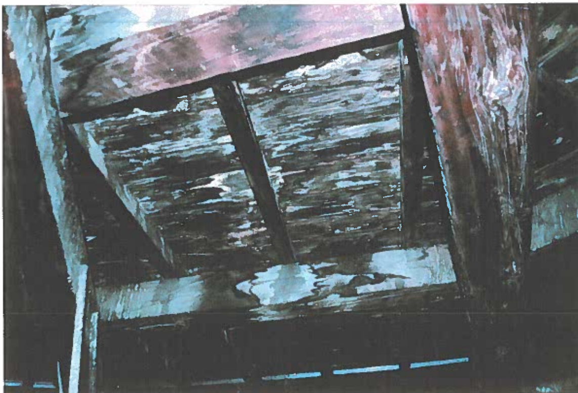
• PHOTO N° 12 - Partie de charpente altérée à cause du mauvais état de la couverture -
