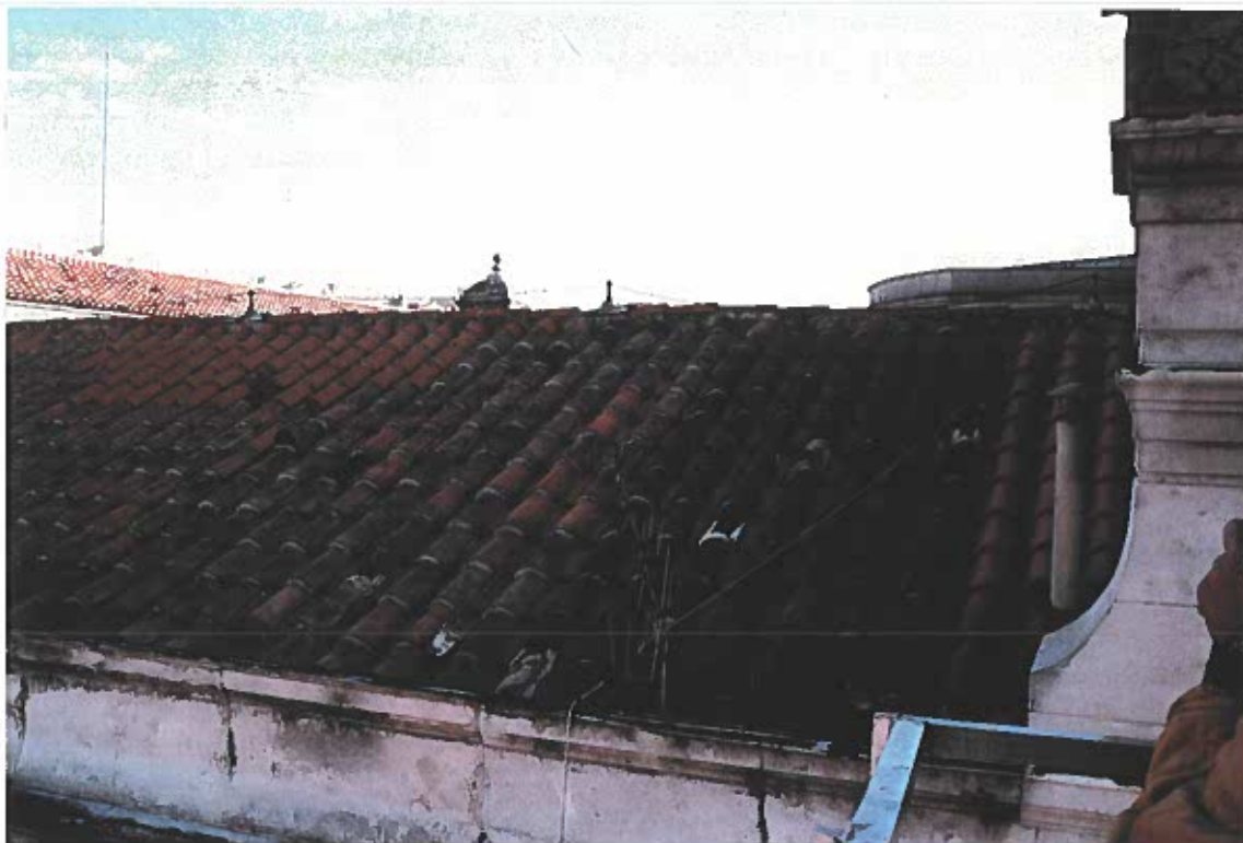
• PHOTO N° 18 - Aile Nord - Pan de couverture Nord - Noter les trous sur la couverture -
