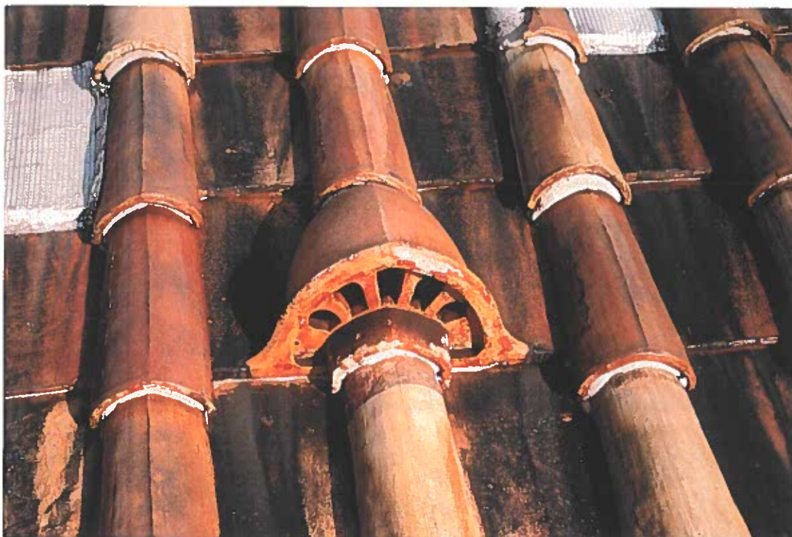
• PHOTO N° 3 - Détail sur tuiles vernissées et chatière de ventilation -
