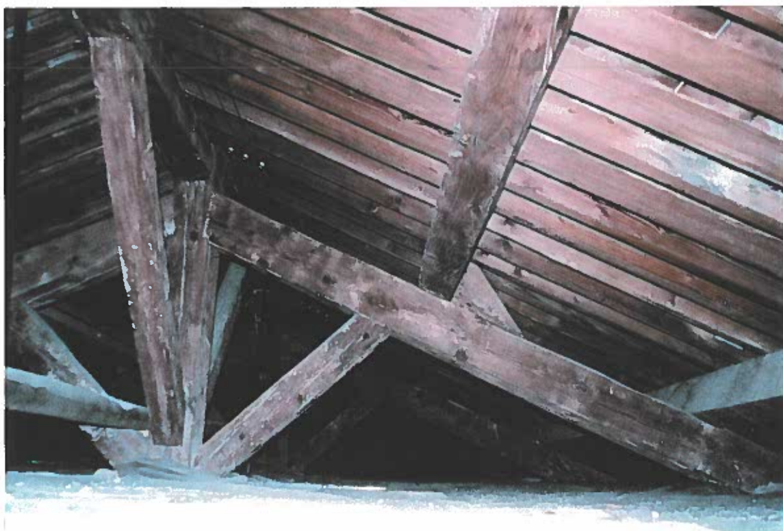
• PHOTO N° 24 - Aile Sud - Les charpentes des ailes Nord et Sud sont en bon état -
