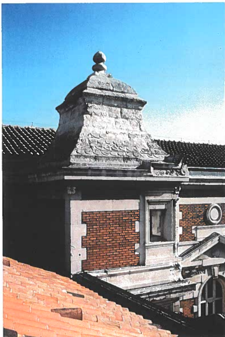
• PHOTO N° 21 - Tourelle Nord - Détail sur altérations de la couverture en pierre de Calissane - Les écailles ont presque disparues - Aux angles de la tour apparaissent les têtes de tirant du chaînage métallique de la tourelle -
