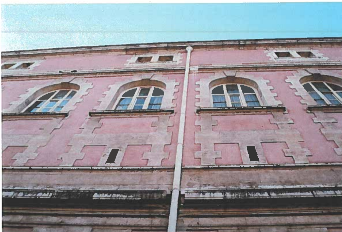
• PHOTO N° 10 - Vue partielle de la façade Est - Le parement est en assez bon état sauf la corniche haute - Les menuiseries des 1 o et 2 o étages sont assez altérées -
