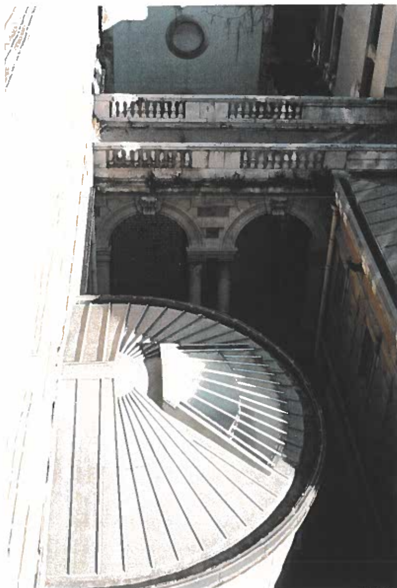
• PHOTO N° 25 - Aile Sud - Couverture sur rotonde Sud en zinc - Bon état général -
