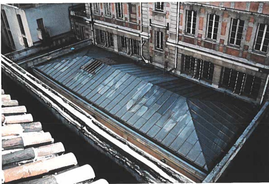
• PHOTO N° 30 - Bâtiment annexe - Couverture en zinc des salles de dessins, aujourd'hui salles de percussions -
