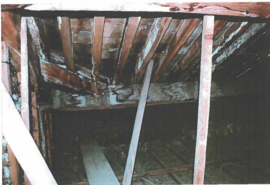
- PHOTO N° 28 - Annexe - Détail sur charpente : Les pièces de grosses sections sont en bon état malgré les traces de fuites de la couverture aisément visibles sur les pannes et chevrons -
