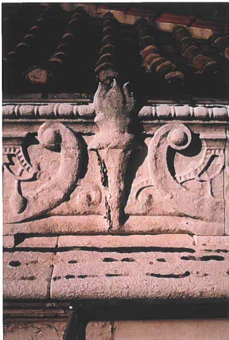
• PHOTOS N° 7 & 8 - Pignon Sud de l'aile Ouest - Détails d'altérations de la corniche et de la frise d'attique : desquamations et exfoliations - Les joints de la corniche ne sont plus étanches -
