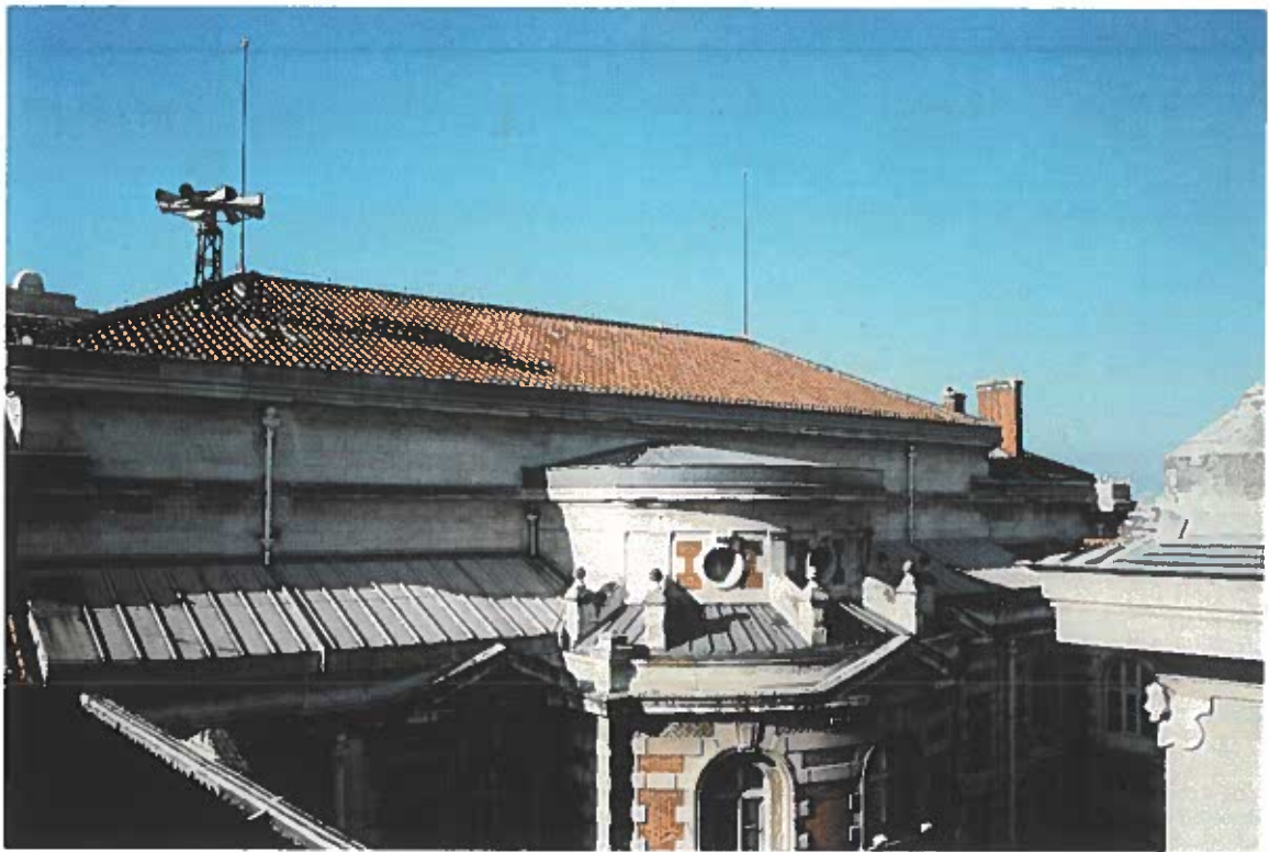
• PHOTO N° 14 - Bâtiment principal - Aile Ouest - Pan Est de la couverture - Les chutes de matière sous la corniche pierre trahissent l'altération des égouts en zinc -
