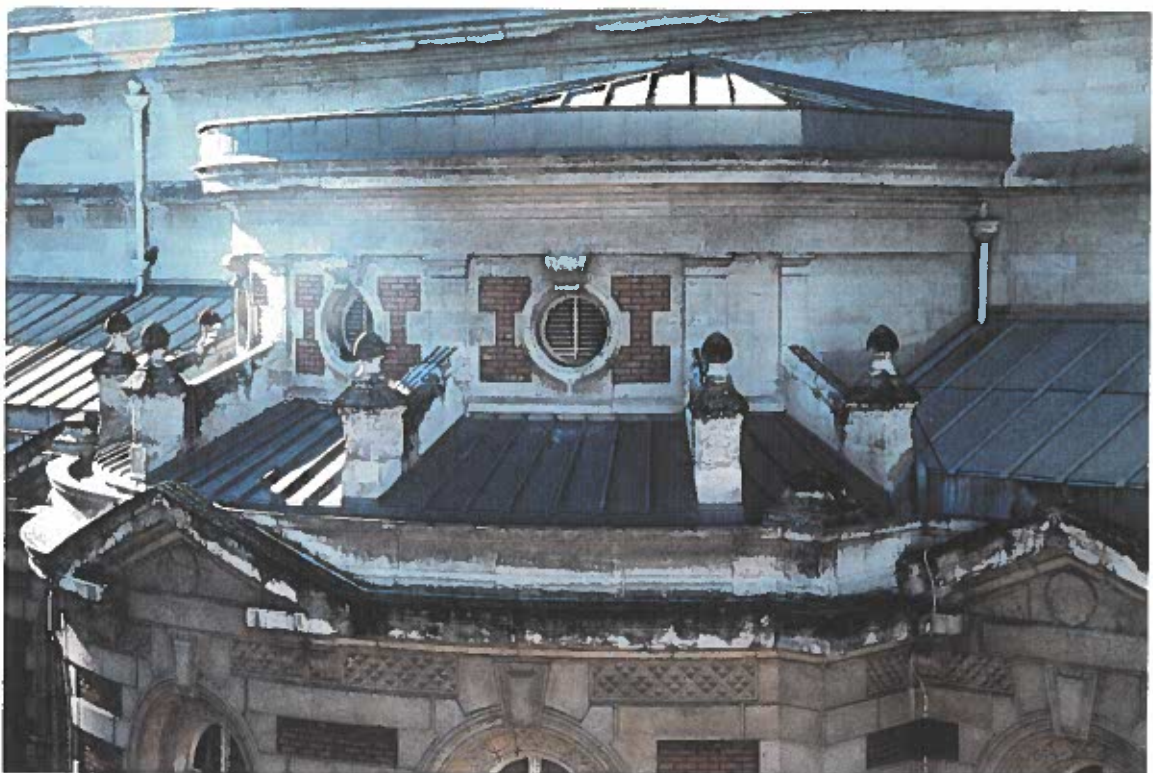
• PHOTO N° 15 - Bâtiment principal - Hémicycle sur Aile Ouest - Détail de couverture en zinc - Les contreforts et leur pomme d'amortissement sont très altérés - Noter les oculi de ventilation - Noter l'altération de la corniche en pierre non protégée par une couvantine -
