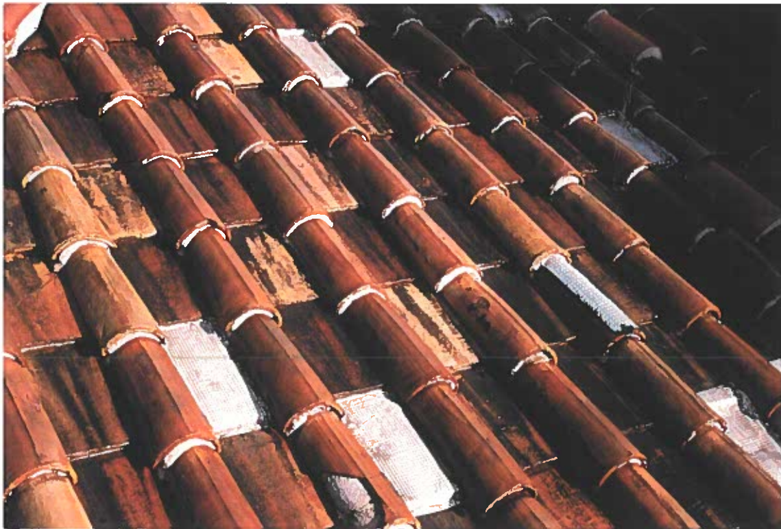
• PHOTO N° 2 - Couverture pan Ouest et Sud - Noter les nombreuses réparations effectuées à l'aide de "paxalu" -
