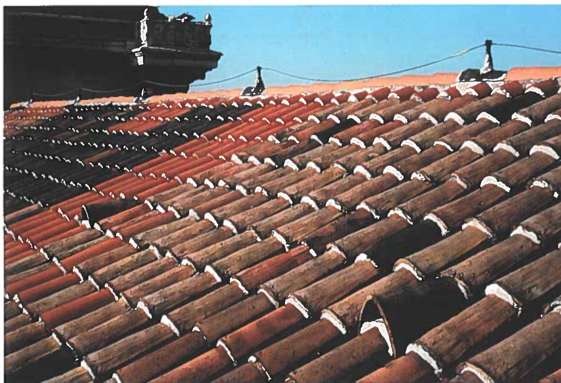
• PHOTO N° 17 - Aile Nord - Pan de couverture Sud - Les couleurs des tuiles correspondent à trois âges de tuiles -
