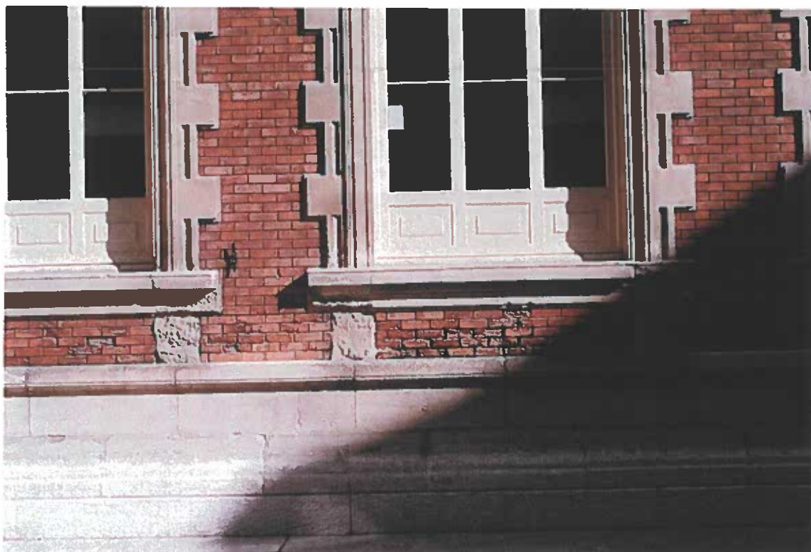
• PHOTO N° 20 - Bâtiment principal - Façades sur cour - Détail d'altération de la façade en partie basse (élévation Ouest) - Désagrégation de la brique et altération des parties en pierre -
