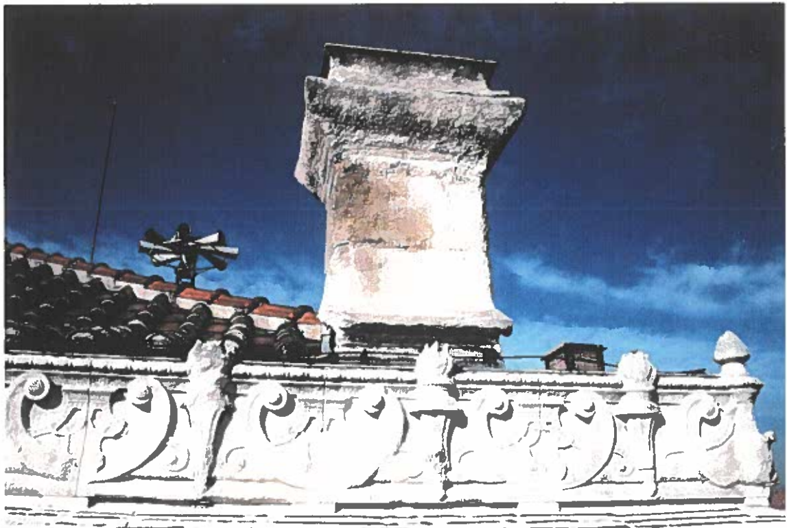
• PHOTO N° 7 - Aile Ouest, angle Sud-Ouest - Cheminée en pierre très altérée du côté Est - Les godrons ont disparus -
