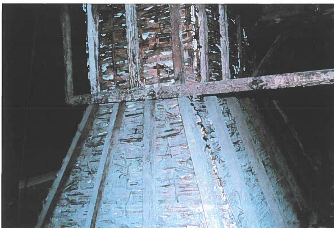
• PHOTO N° 13 - Structure du lanterneau situé sur le pan Nord-Est de la couverture de l'aile Ouest - Lanterneau à conserver -
