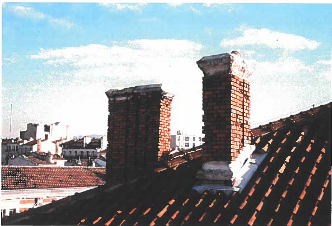
• PHOTO N° 9 - Cheminées très dégradées à l'angle Nord-Est -
