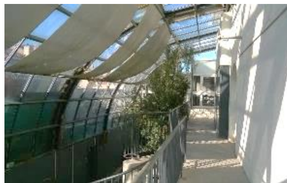
Vue depuis la passerelle vers l'extension
