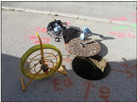
**Figure 5 : Exemple du passage d'une aiguille détectable couplé à un générateur (mode actif) dans un réseau gravitaire.**
