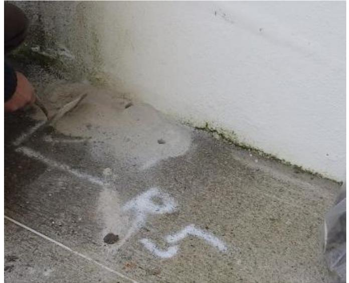
La présence de ferrailage a engendré pour les 2 reconnaissances des refus prématurés dans la fondation (assise > 0,50 m de profondeur).
