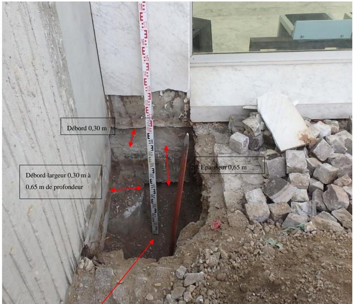
Refus pelle à 1 m / TA de profondeur sur dalle béton
