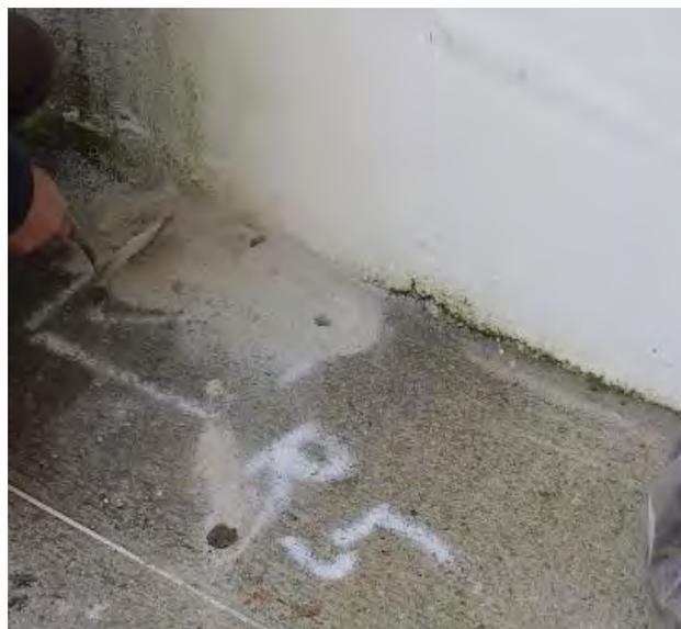
La présence de ferrailage a engendré pour les 2 reconnaissances des refus prématurés dans la fondation (assise > 0,50 m de profondeur).
