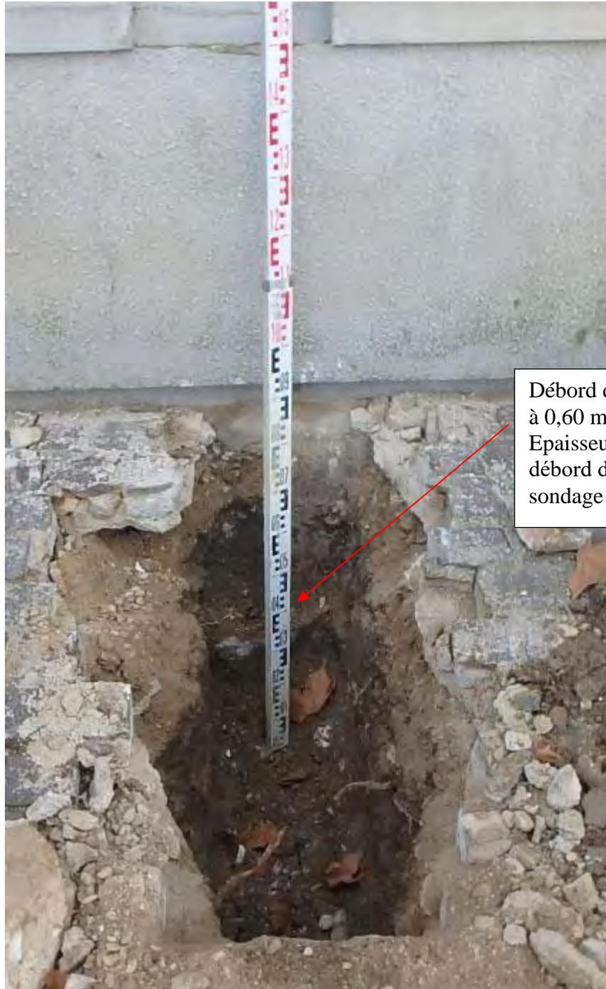
Débord de 0,30 m de largeur à 0,60 m de profondeur. Epaisseur minimale de ce débord de 1,30 m d'après sondage au perforateur réalisé
