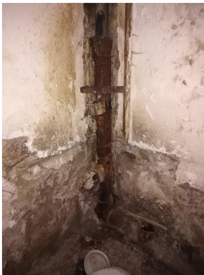
Canalisations, humidité du mur et de l'enduit décollé
