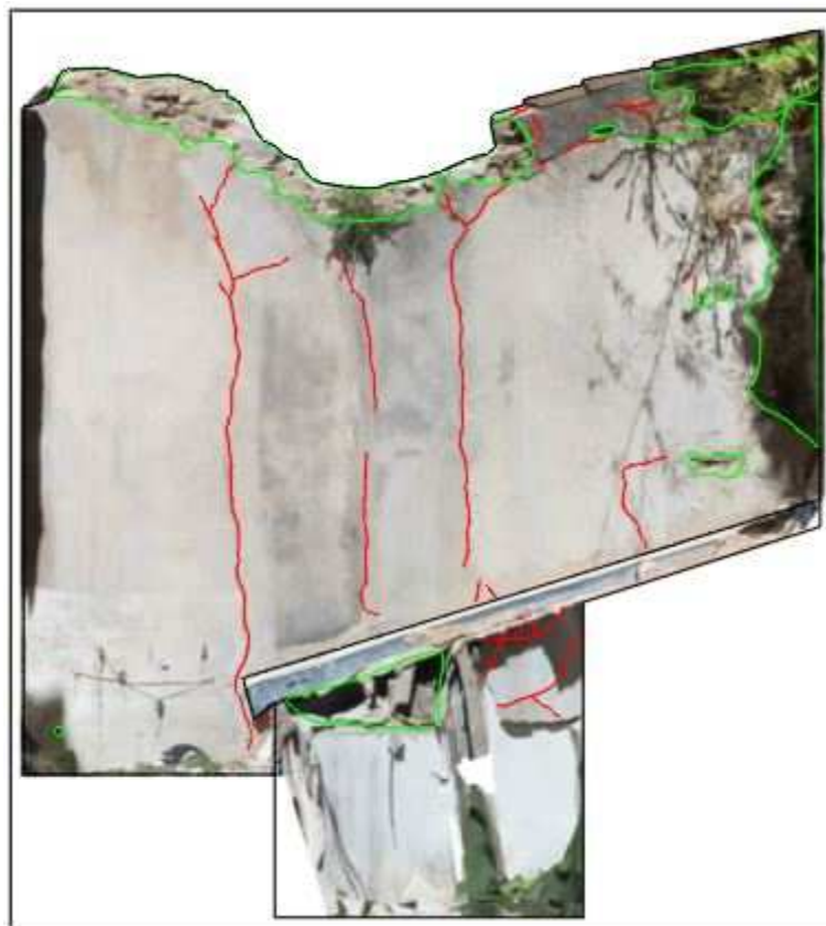
Façade Nord n°67 rue d'Aubagne : orthomosaique avec report de désordres
