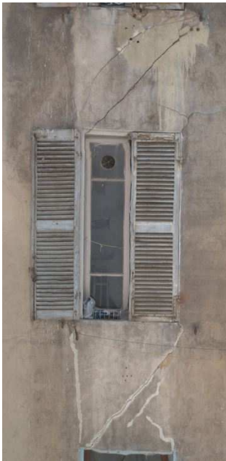
Zoom sur orthomosaïque du n°79 avec fissures d'ouverture supérieure à 1cm.
