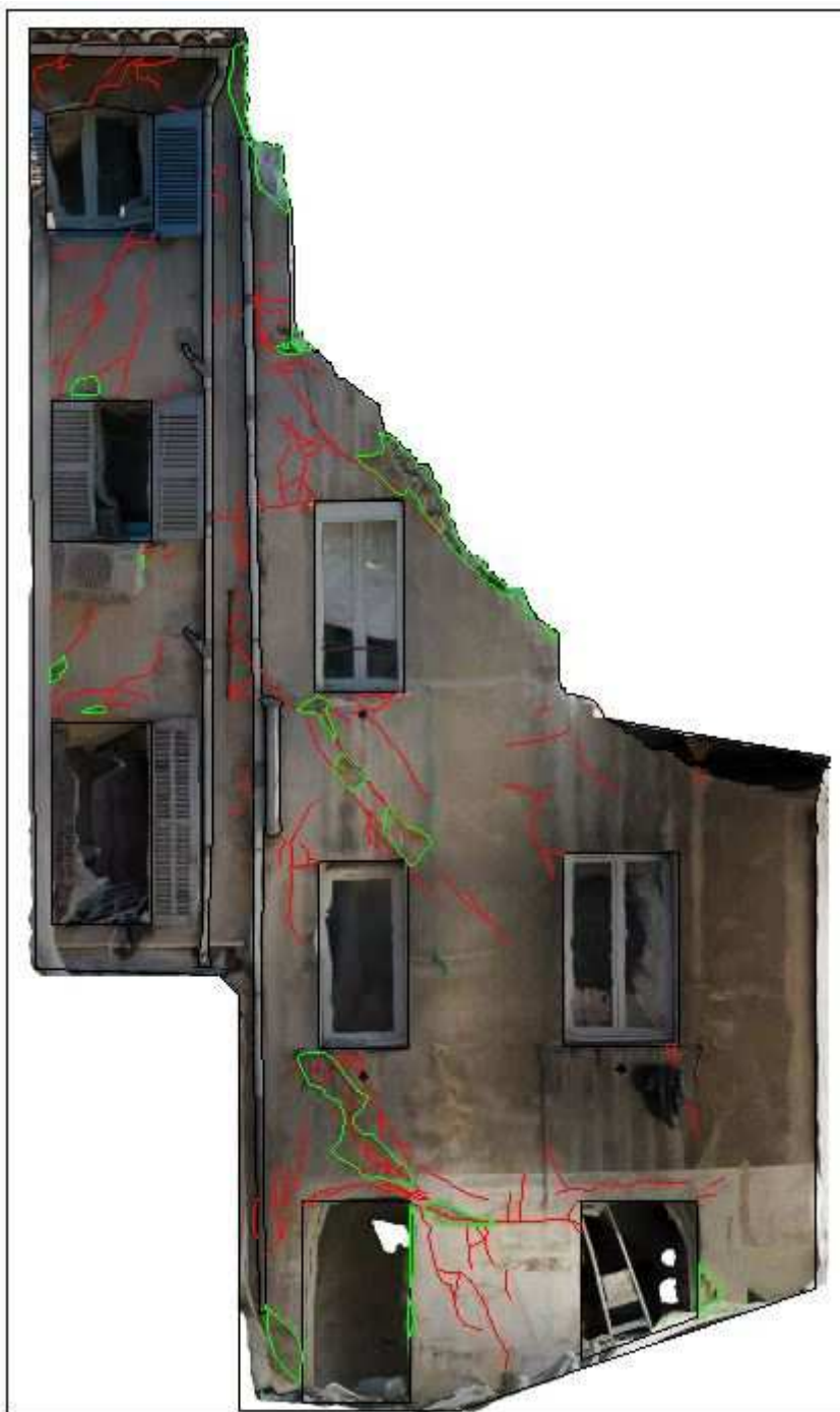
Façade Est n°67 rue d'Aubagne : orthomosaique avec report de désordres
