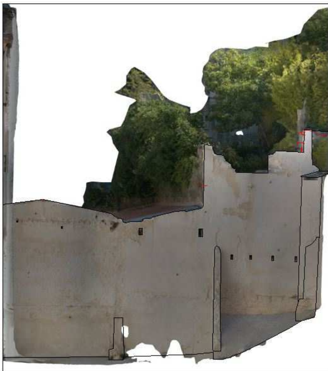
Façade Ouest n°63 rue d'Aubagne : orthomosaïque avec report de désordres
