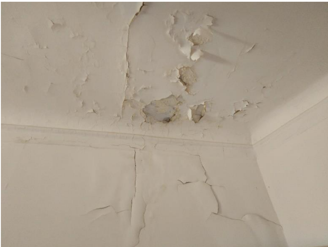
Humidité et cloquage de la peinture du plafond
