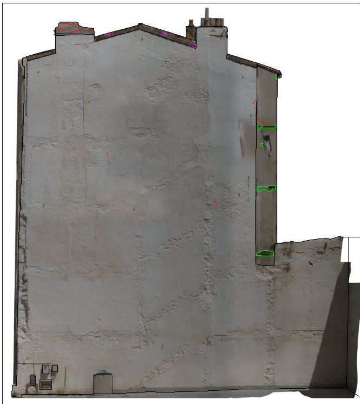
Façade Nord n°63 rue d'Aubagne : orthomosaique avec report de désordres
