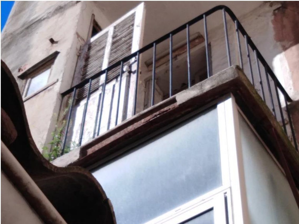
Poutres métalliques de rive corrodées
