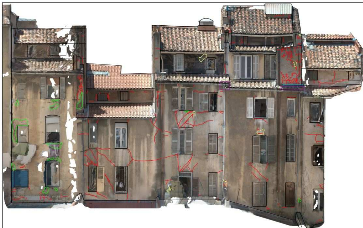
Façade Ouest n°75 à 83 rue d'Aubagne : orthomosaïque avec report de désordres
