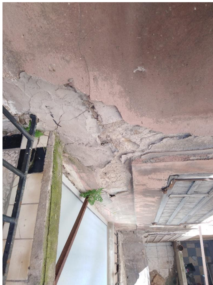
Décroulage de l'enduit au droit des appuis des balcons
