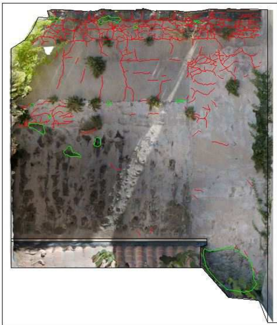
Façade Ouest n°67 rue d'Aubagne : orthomosaïque avec report de désordres
