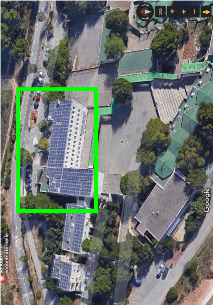
Localisation du bâtiment
