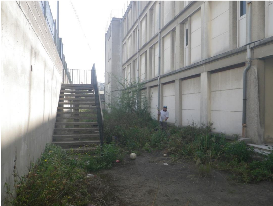
Figure 5 : Photographie de la « douve » au niveau de l'école élémentaire
