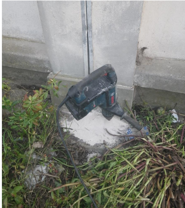
Figure 6 : Photographie de la reconnaissance de fondations du pilier (RF5)
