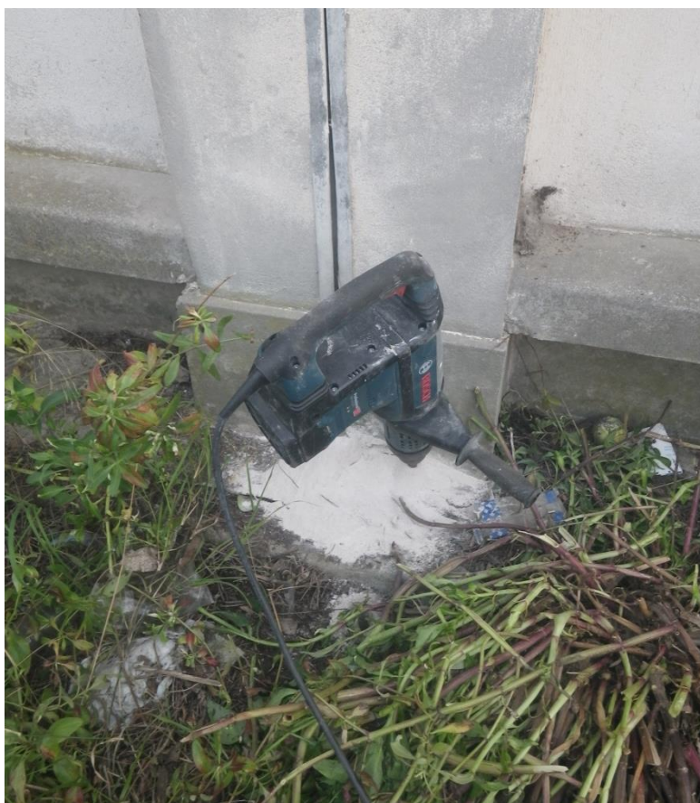
Figure 6 : Photographie de la reconnaissance de fondations du pilier (RF5)
