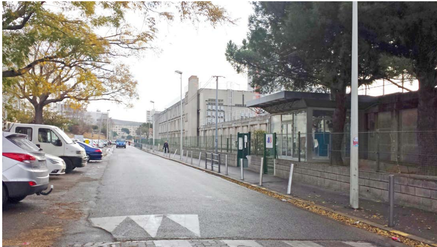
1 - Photographie de loin : Façade Nord sur rue Douriant
