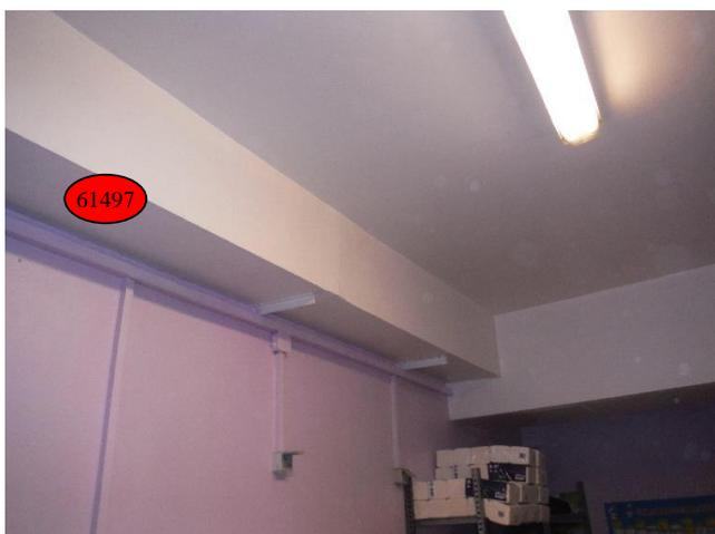
Conduit de ventilation du bureau cuisine RDC contenant de l'amiante après analyse. Echantillon 61497.
