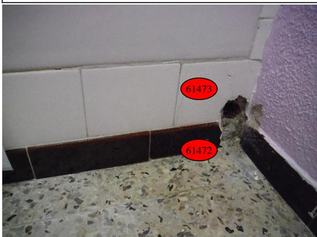
Colle de plinthe 1 contenant de l'amiante après analyse présente en RDC. Echantillon 61472.
