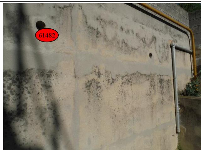
Conduits de drainage des douves contenant de l'amiante après analyse. Echantillon 61482.
