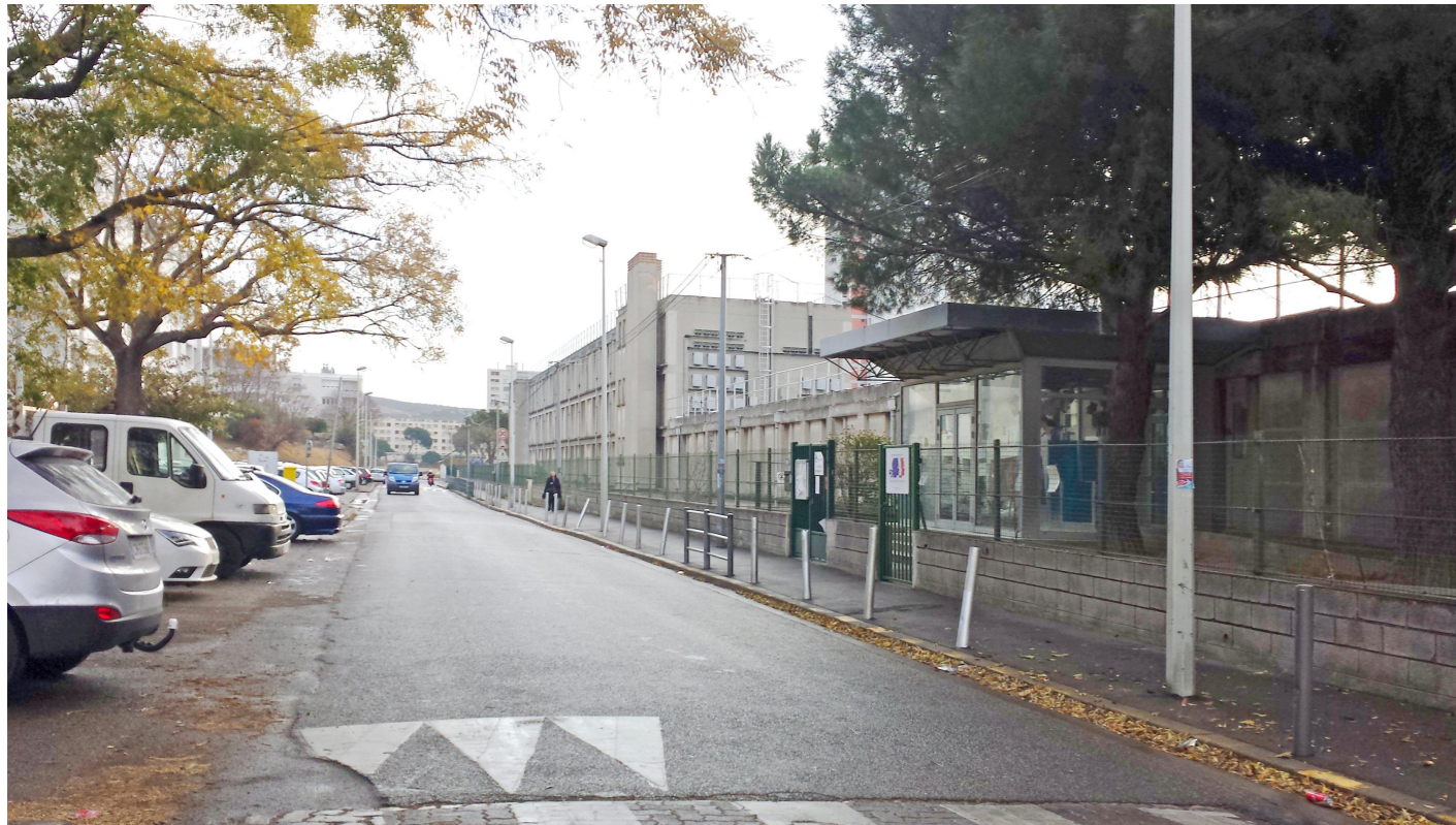
1 - Etat actuel - Vue d'ensemble du groupe scolaire sur rue Douriant
