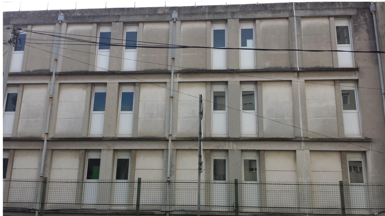
2 - VUE D'ENSEMBLE FACADE RUE DOURIANT
