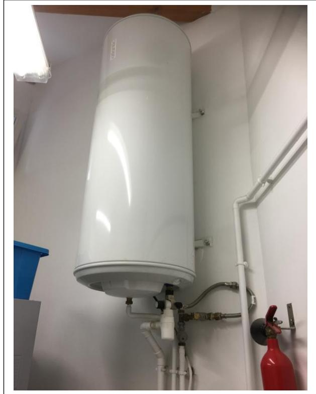
La production d'Eau Chaude sanitaire est réalisée localement par chauffe-eau électrique.
