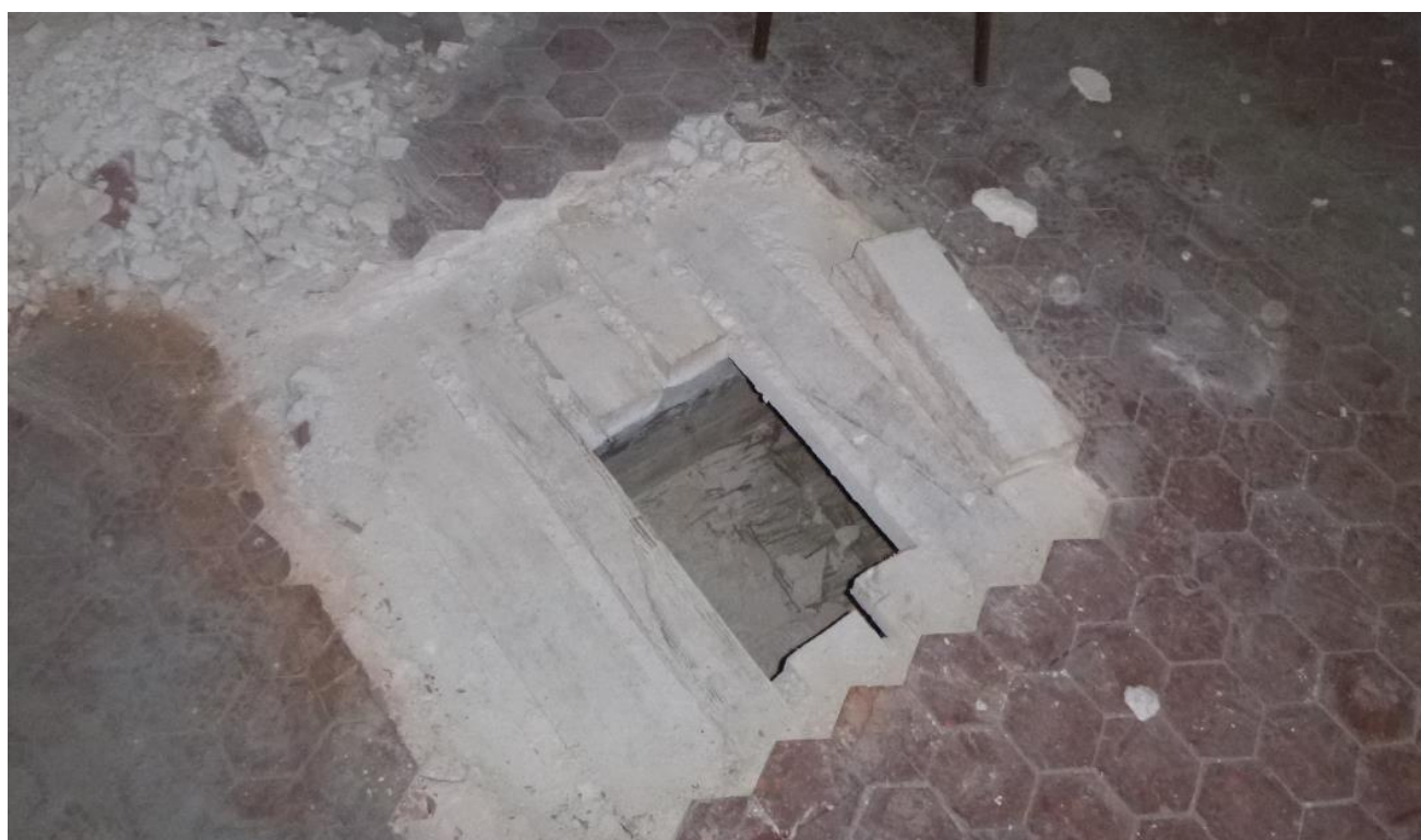
Photo 16 Correspondant au sondage relevé en salle 2.39
