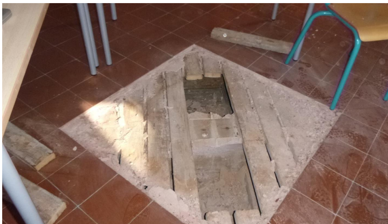
Photo 14 Vue du sondage en plancher
