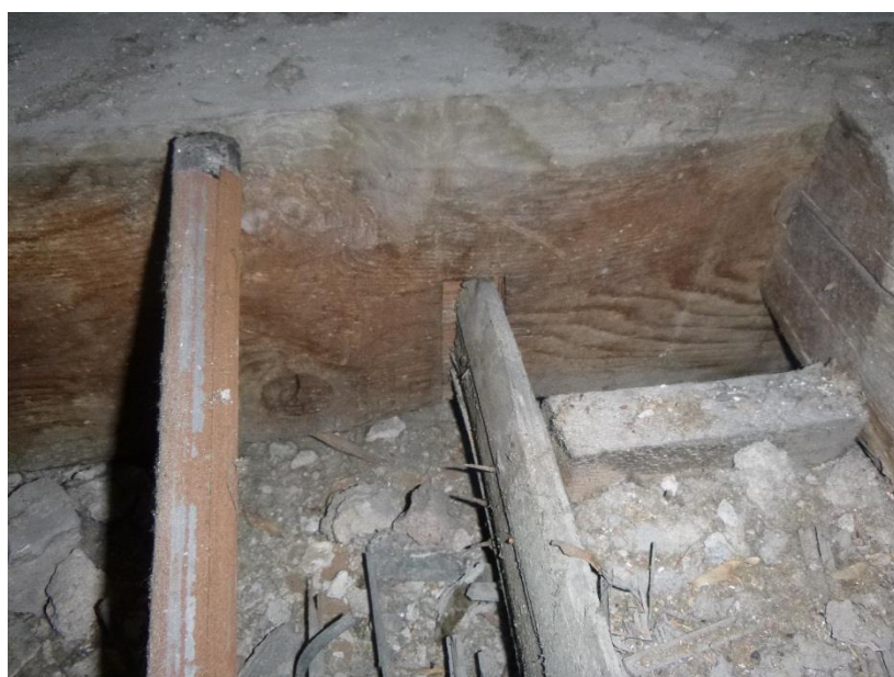
Photo 22 Appuis des bastings support des plafonds
