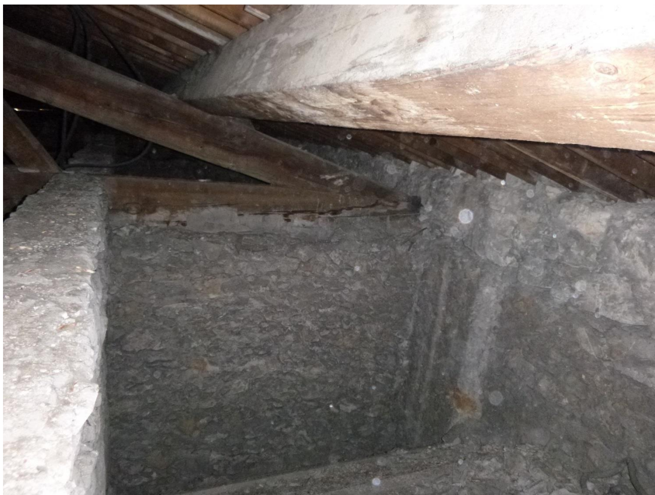
Photo 20 Appui d'une demi-ferme sur les refends du bas-côté
