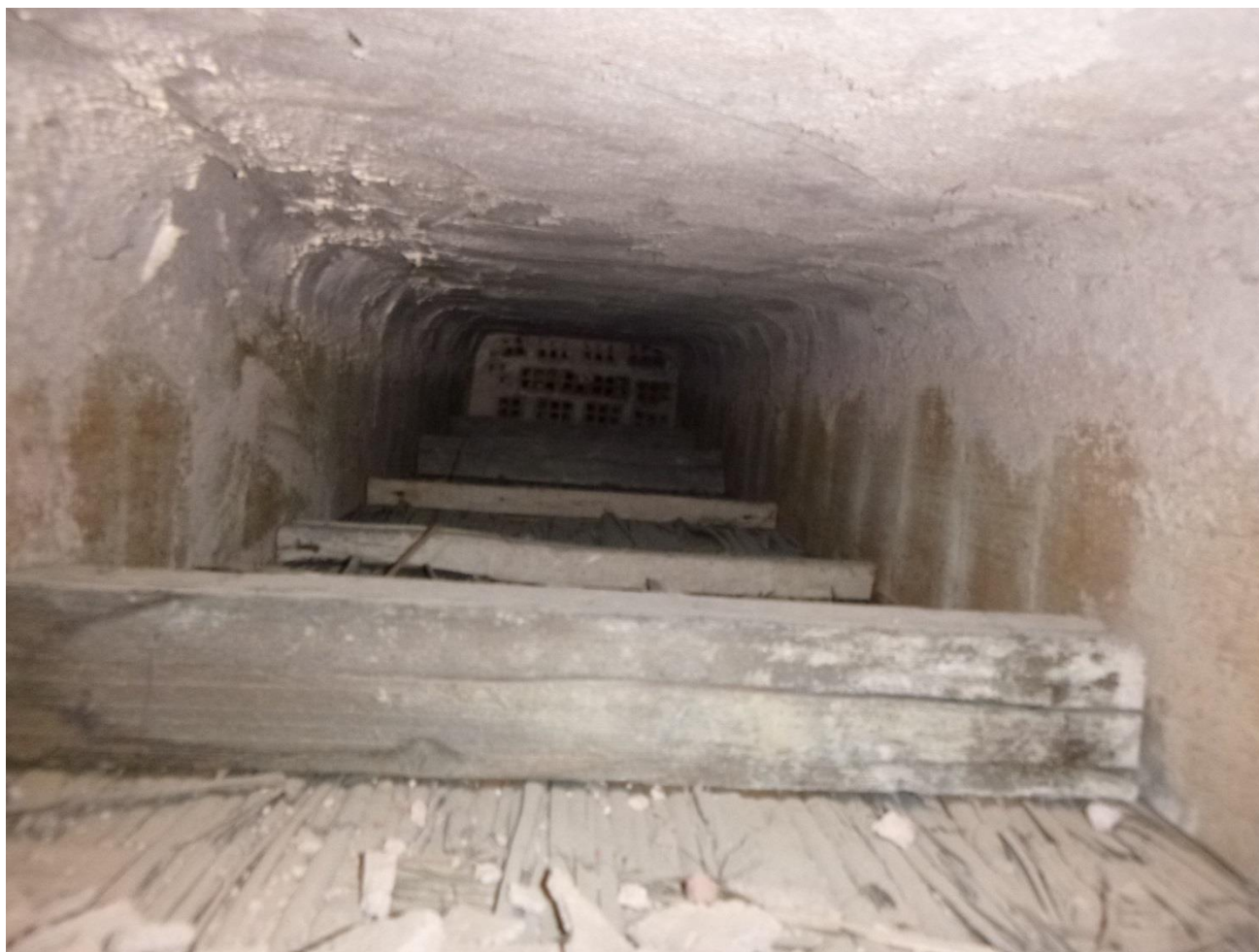
Photo 15 Vue intérieur du plancher
