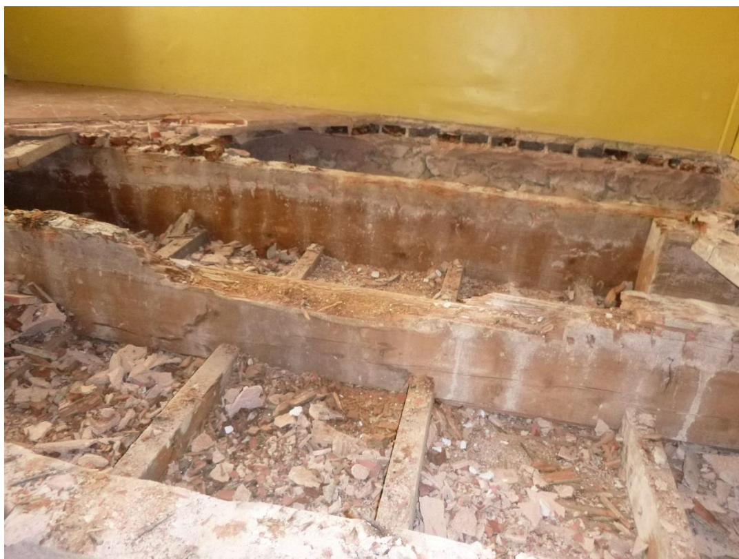
Photo 13 Correspondant au sondage relevé en salle 1.5
