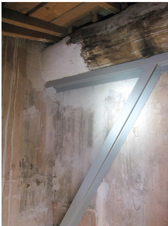
Photo 24 About de panne altéré reprise en sous œuvre par console métallique
