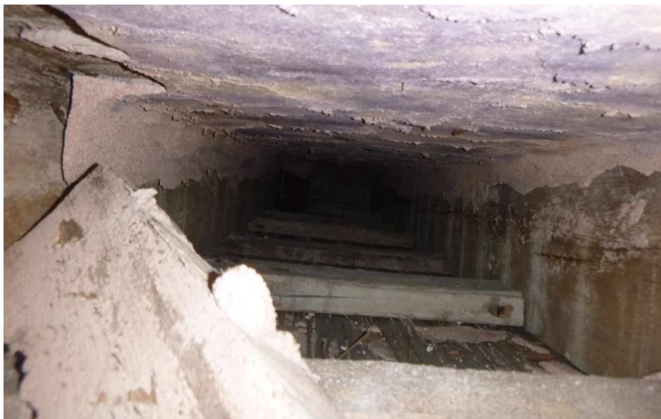
Photo 6 Vue des ossatures porteuses
