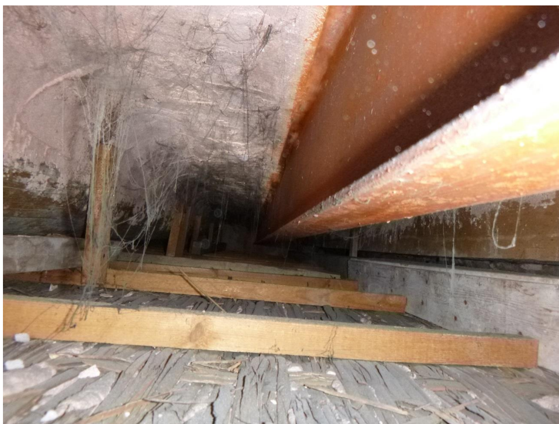
Photo 17 Correspondant au sondage relevé en salle 2.12
