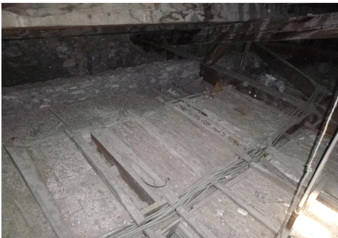
Photo 21 Vue des ossatures des plafonds des bas-côtés
