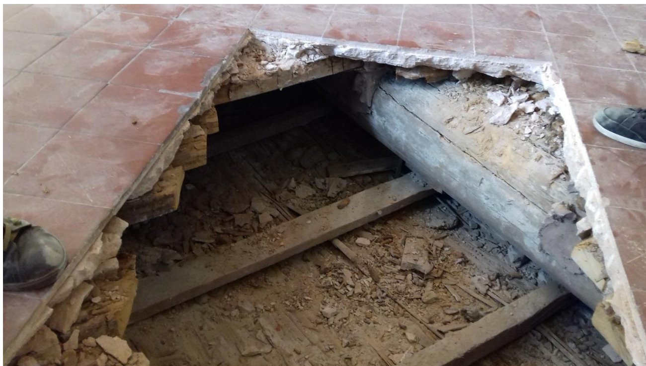
Photo 3 Correspondant au sondage relevé en salle 1.2 - portée 8,30 m
