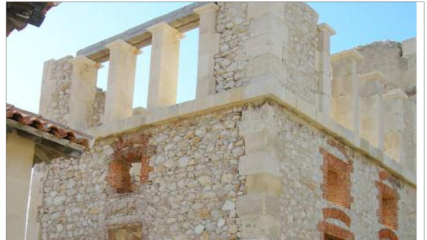
Murs en moellons - encadrements en brique -bandeaux, piliers et chaîne d'angle en pierre de taille
